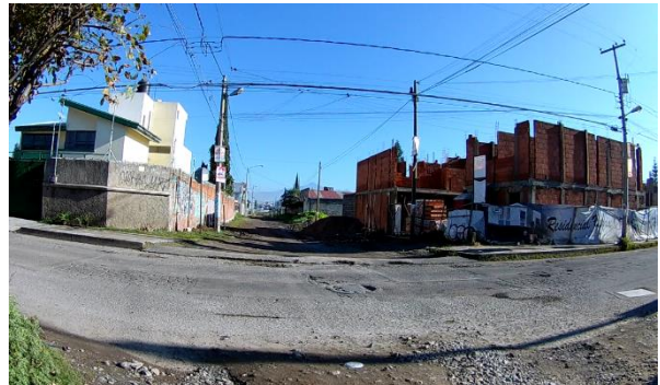
Calle sin pavimentar. 16 de septiembre A poniente y en la esquina Construcción de nuevo conjunto habitacional cerrado: Residencial Bega (Dic 2018)
