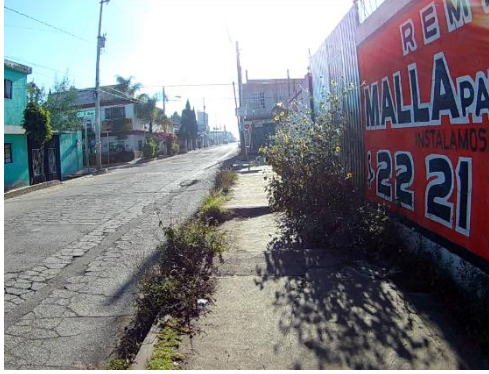
Banqueta sin mantenimiento en 119 poniente entre 12 de octubre y 3 sur. Recorridos en Granjas Puebla (Dic 2018)
