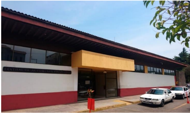
Imagen 8 Fachada Noroeste de la terminal de autobuses. Pátzcuaro, Michoacán. Fuente: Google Maps junio 2019
