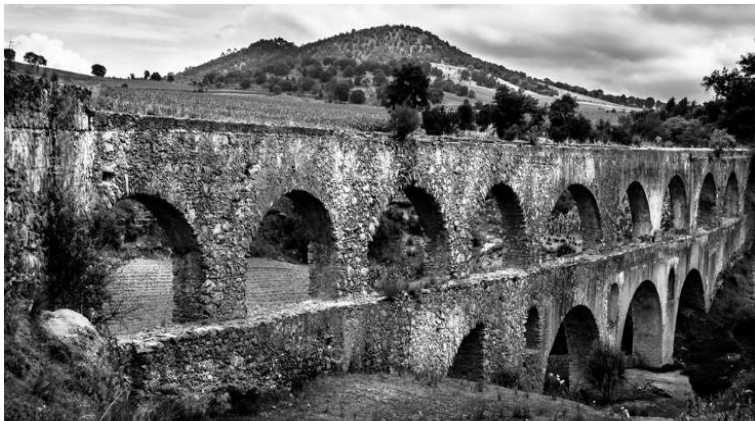
Imagen 4 Acueducto en San Juan Arcos, Ojo de agua. Puebla, Fuente Obed Palacios 2015
