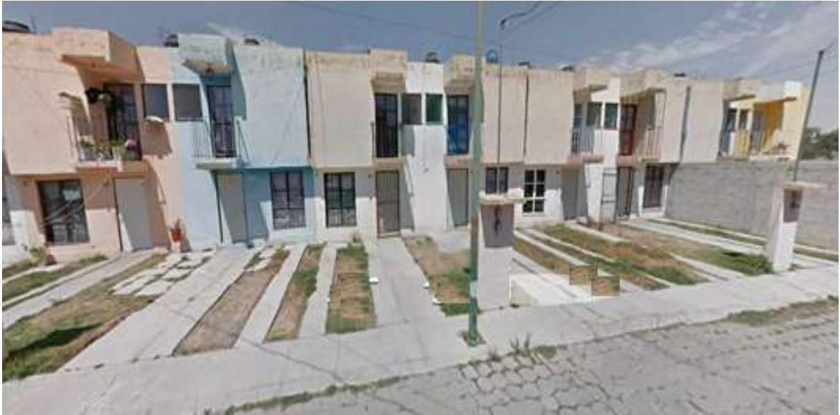
Figura 22-CG. Conjunto Habitacional, calle Lagunilla.
