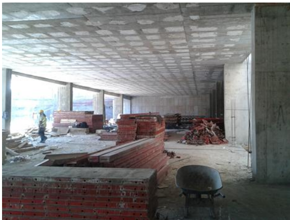
Figura 3.21 Descimbra de sótano
