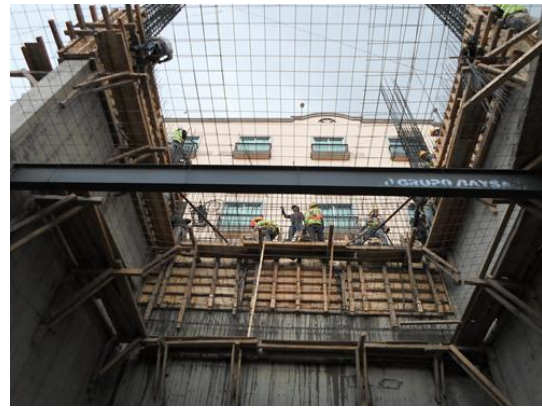
Figura 3.24 Muros de cortante
