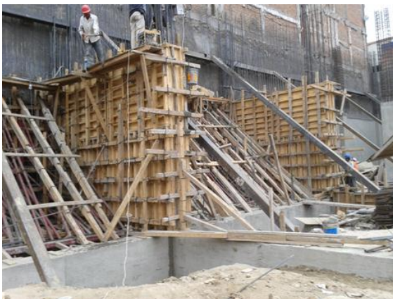
Figura 3.16 Muros cortante de elevadores
