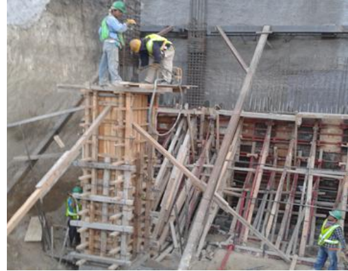
Figura 3.13 Cimbra y colado de columnas
