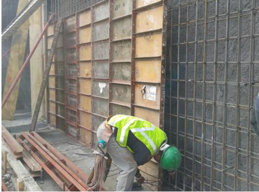
Figura 3.12 Cimbra de muros
