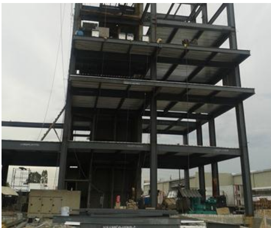
Figura 3.27 Colocación de losacero
