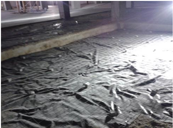
Figura 3.25 Preparación firme
