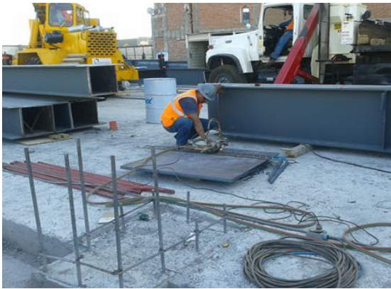
Figura 3.23 Cortes y ensambles de columnas
