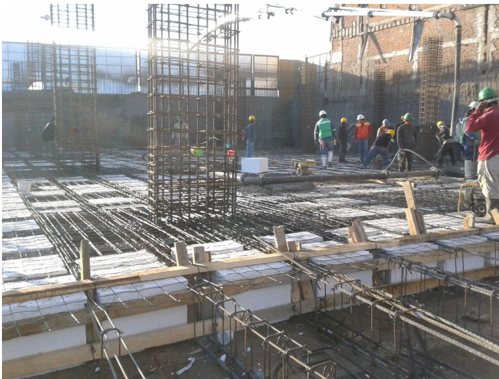
Figura 3.45 Losa de estacionamiento
