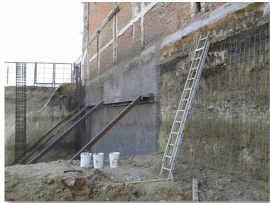
Figura 3.9 Apuntalamiento de talud
