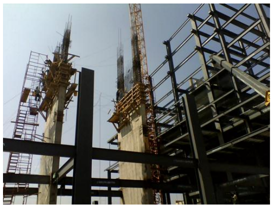
Figura 3.26 Armado de estructura metálica
