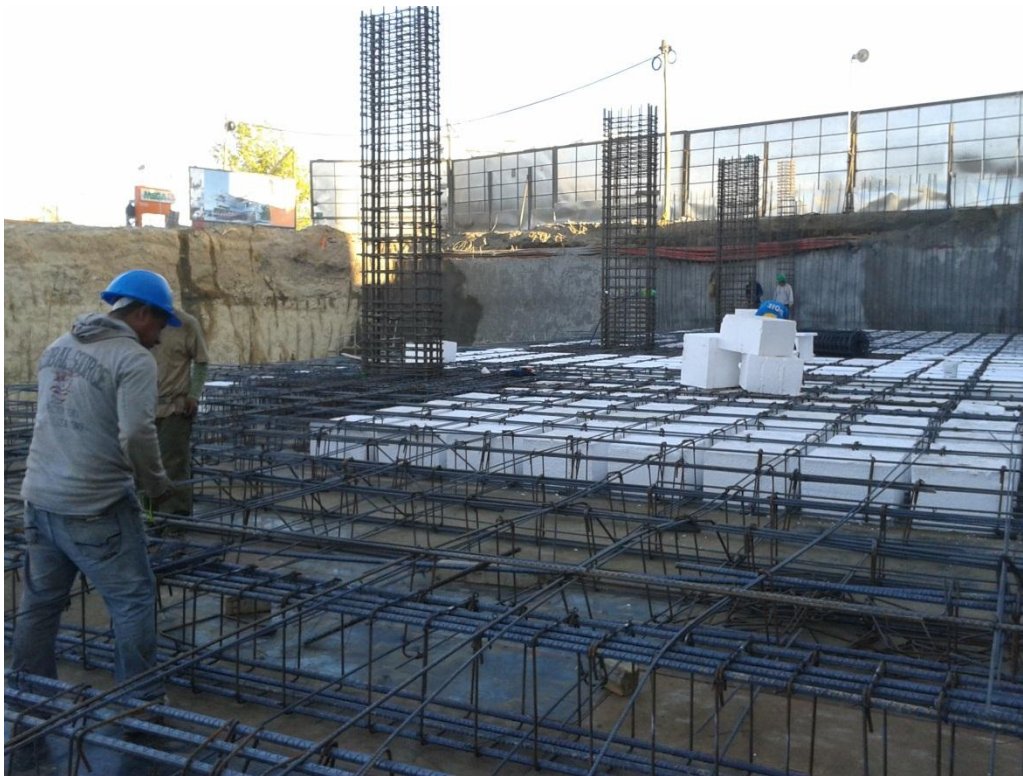
Figura 3.44 Losa de estacionamiento
