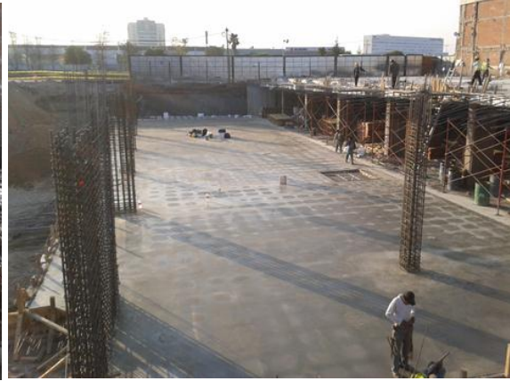
Figura 3.20 Colado de losa sótano
