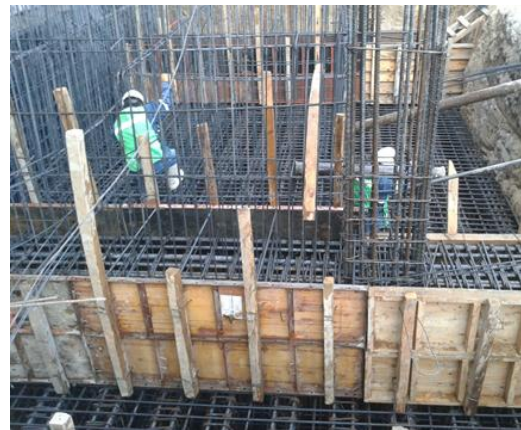
Figura 3.15 Cimbra de núcleo de elevadores
