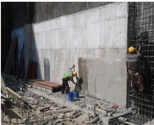
Figura 3.14 Colado muros de contención
