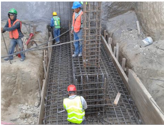
Figura 3.10 Armado de zapata
