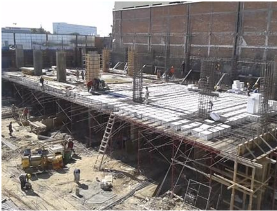
Figura 3.19 Armado de sótano
