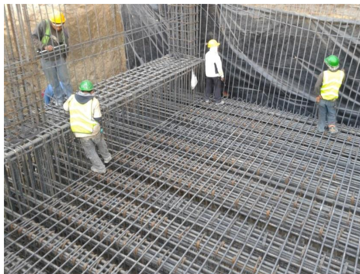
Figura 3.29 Losa de cimentación LC-1
