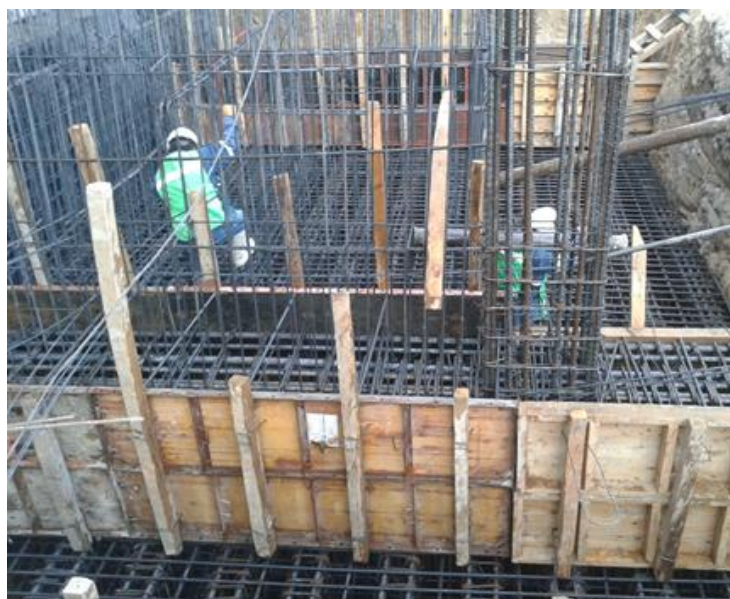
Figura 3.30 Losa de cimentación LC-1
