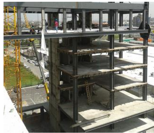
Figura 3.28 Colado de losacero
