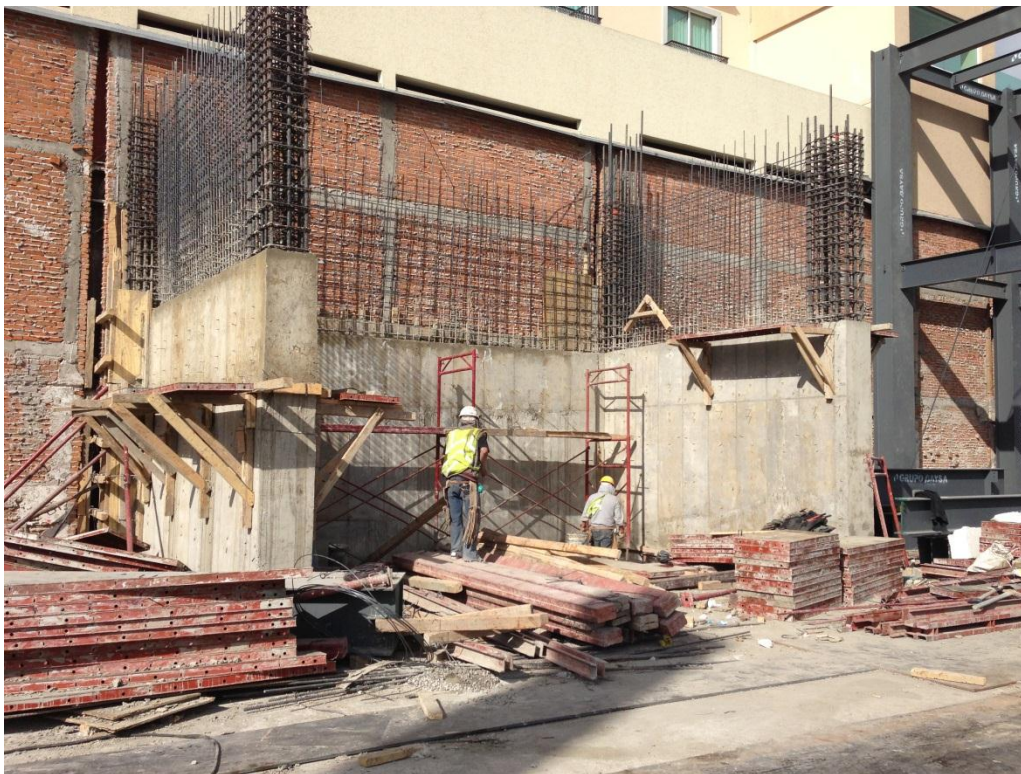
Figura 3.39 Muro de cortante MC-2
