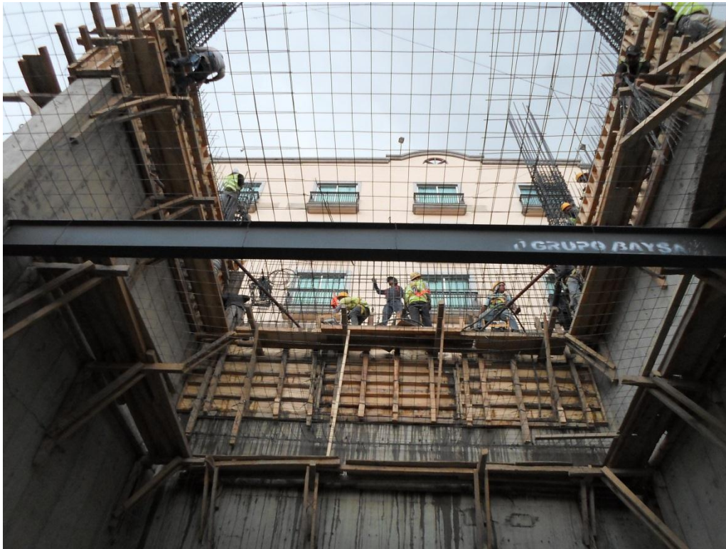
Figura 3.38 Muro de cortante MC-2
