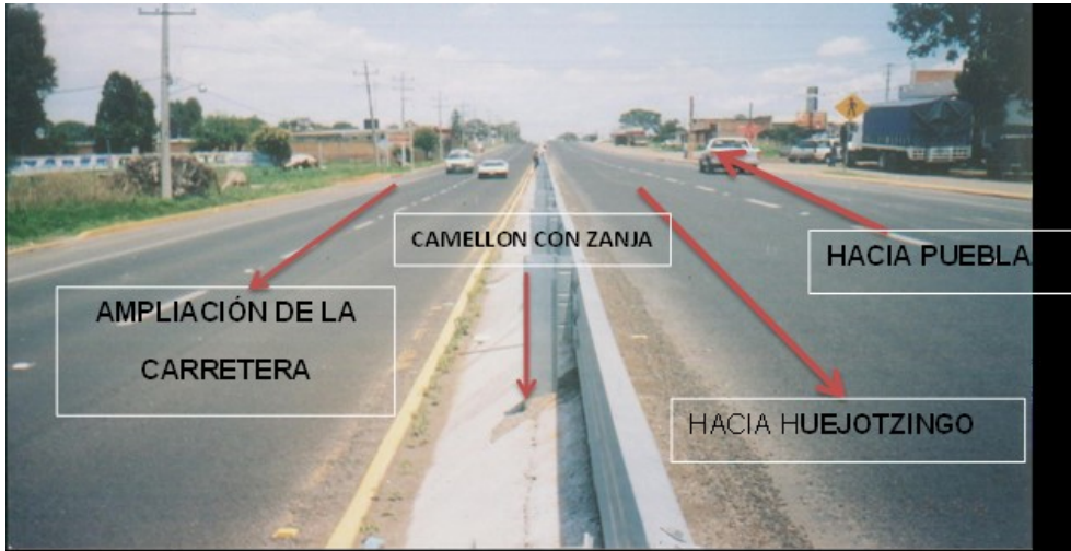
Figura 4.13: Carretera a San Martín
