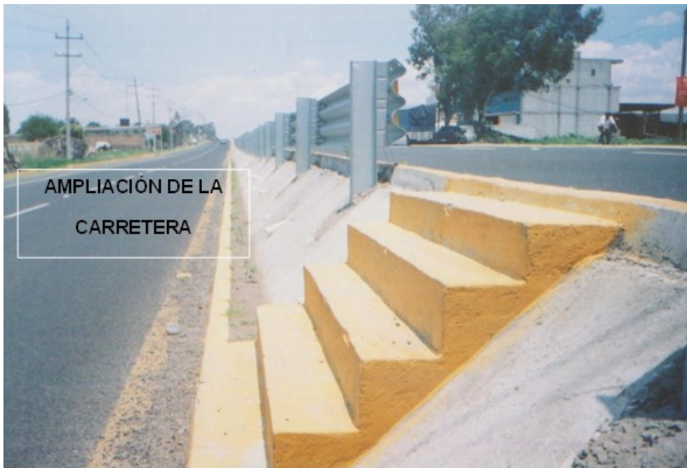
Figura 4.14: Ampliación de la carretera
