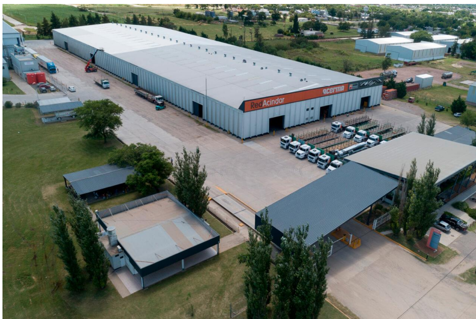
Figura 3.1.6- Ejemplo de rugosidad de superficie de categoría "C". Nave industrial con obstrucciones dispersas
