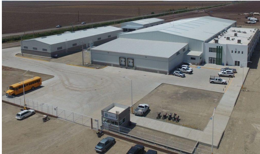
Figura 3.1.7- Ejemplo de rugosidad de superficie de categoría "D". Nave industrial en áreas planas y sin obstrucciones
