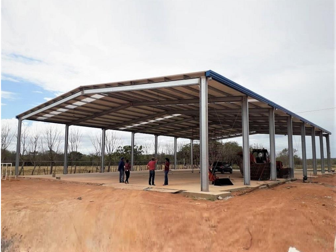
Figura 3.1.11- Ejemplo de nave industrial clasificada como abierta
