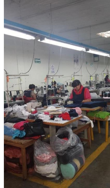
Imagen 13 Funcionamiento de alumbrado general localizado.
