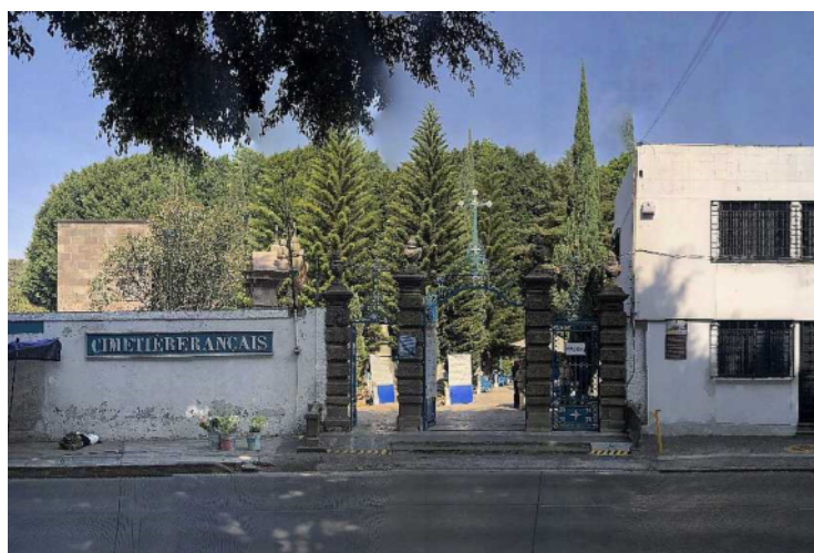
Figura 42 . Detalle de acceso al panteón sobre la calle 11 sur. (Fotografía ADGO)
