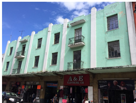
10 Poniente No. 114, Departamento 4 74 m2 de construcción Fuente: elaboración propia
