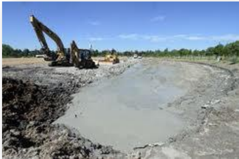
[Figura 2]. Etapa de construcción del Parque del Arte. (2008) Recuperado de http:// ecoaventurapuebla.blogspot
