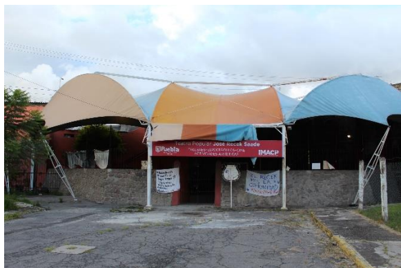
Imagen 1. Vista de la entrada del Teatro José Recek Saade desde Avenida del Puente. (Fotografía tomada por Flores, 2023)
