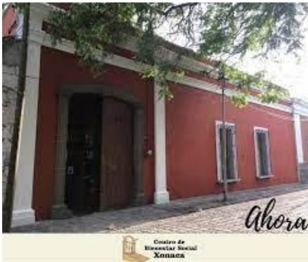
Imagen 40. Fachada de "La Casa del Obispo" (CEBIS Xonaca, 2020) https://nicelocal.com.mx/puebla/entertainment/centro_de_bienestar_social_cebis_xonaca/
