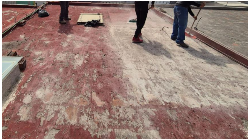
Ilustración 25. Limpieza de techumbre.
