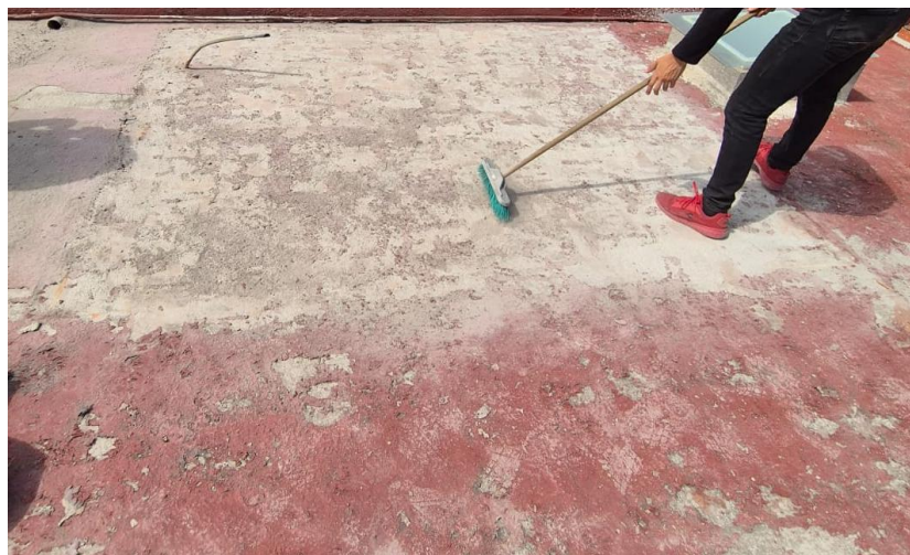
Ilustración 26. Limpieza de techumbre.
