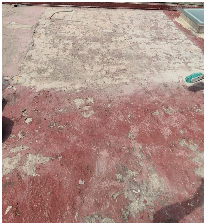
Ilustración 27. Limpieza de techumbre.
