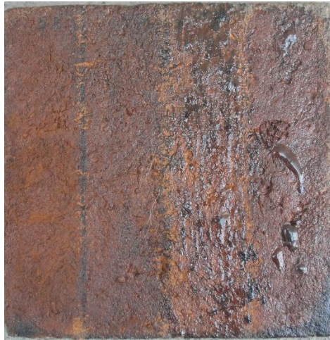
Ilustración 43. Aplicación en ladrillo.
