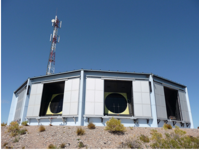
Figura 2.3: Edificio FD en la estación Los Leones, detrás del edificio hay una torre de comunicación. La fotografía fue tomada cuando se abrieron las persianas por mantenimiento. Imagen tomada de [16].
