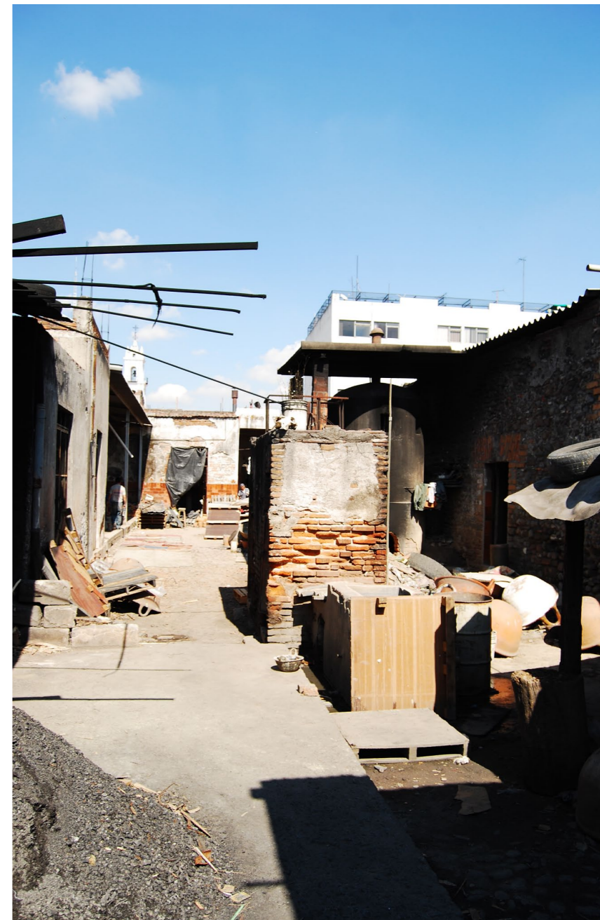
INTERIOR DE LA CASA ALFARERA DEL BARRIO DE LA LUZ La falta de capacidad para el mantenimiento del inmueble ha provocado el deterioro del lugar, las paredes se desgastan lentamente y algunos cuartos incluso han perdido el techo, las condiciones poco a poco amenazan el futuro de los alfareros, quienes aún con tantas carencias, continúan subsistiendo de este oficio.
