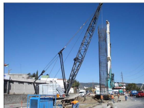
COLOCACION DE ACERO PARA PILA DE CIMENTACION
