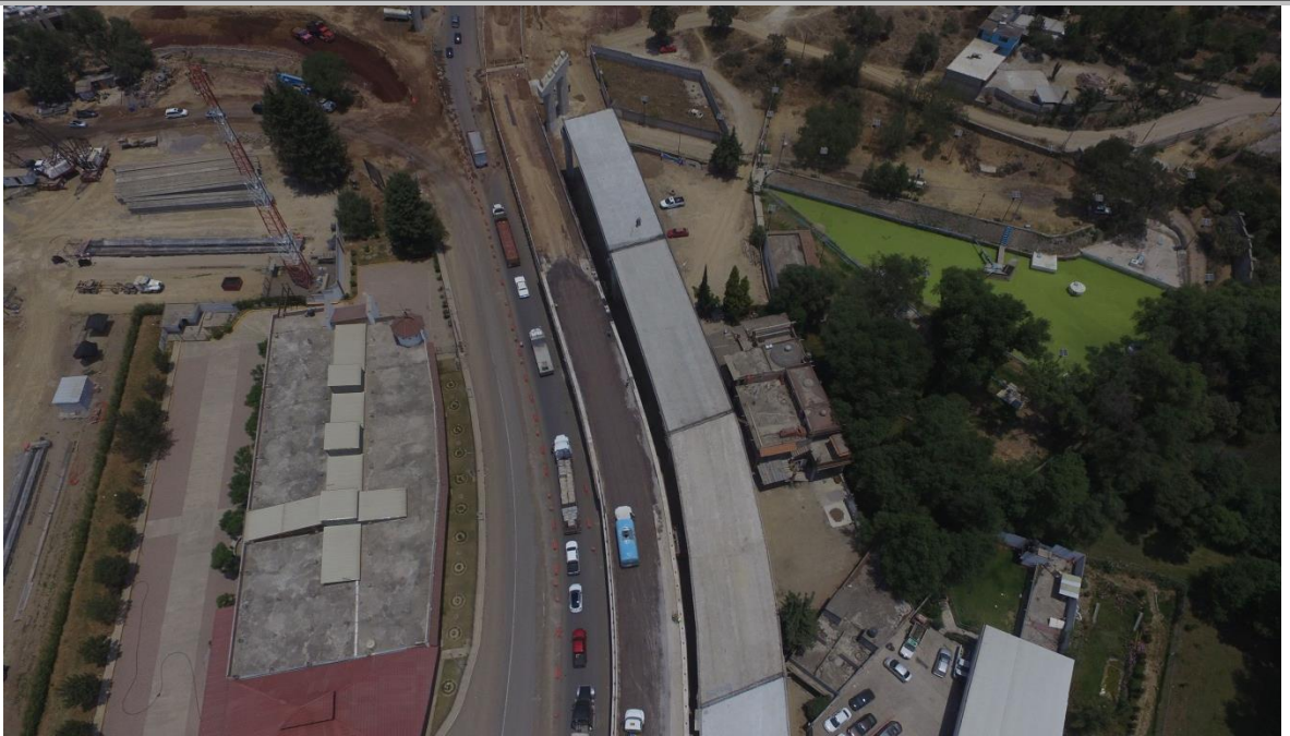
COLOCACION DE TRABES DE ACERO VISTA EN PLANTA
