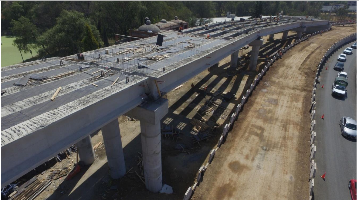
COLADO DE PILA ESPECIAL PARA RECIBIR TRABES DE ACERO
