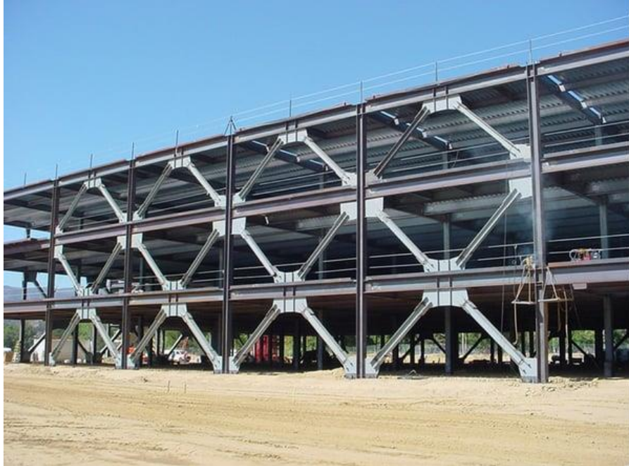
Imagen 13 Ejemplo de arriostramiento lateral Empresa Laminas y Aceros de Yucatán, S.A. de C.V
