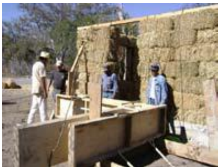
Figura 37. Proceso de colocación de piezas de triplay. Recuperado de: Guía práctica para comunidades indígenas, (2016).
