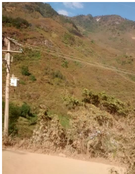
Figura 16. Electrificación (Formal), (tomada 11/02/2017) por Alejandra Rosales Madrid.
