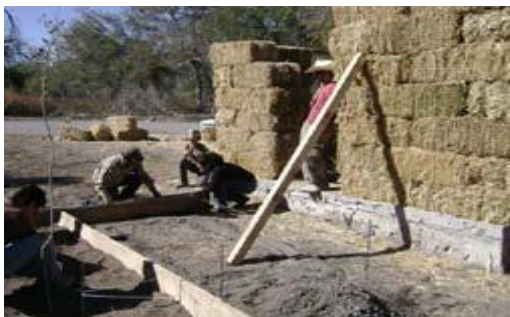
Figura 35. Proceso de construcción para el sanitario seco. Recuperado de: Guía práctica para comunidades indígenas, (2016).
