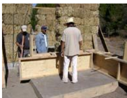
Figura 37. Proceso de colocación de piezas de triplay. Recuperado de: Guía práctica para comunidades indígenas, (2016).
