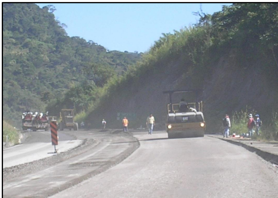
Figura 3.3.11.- Formación y compactación de base estabilizada
