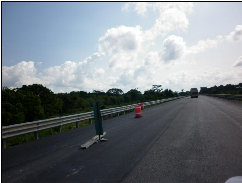
Figura 3.1.4.- Subtramo en reparación Coatzacoalcos – Tuxtla Gutiérrez
