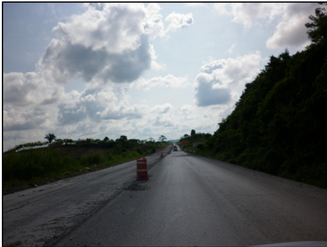
Figura 3.1.5.- Subtramo en reparación Coatzacoalcos – Tuxtla Gutiérrez
