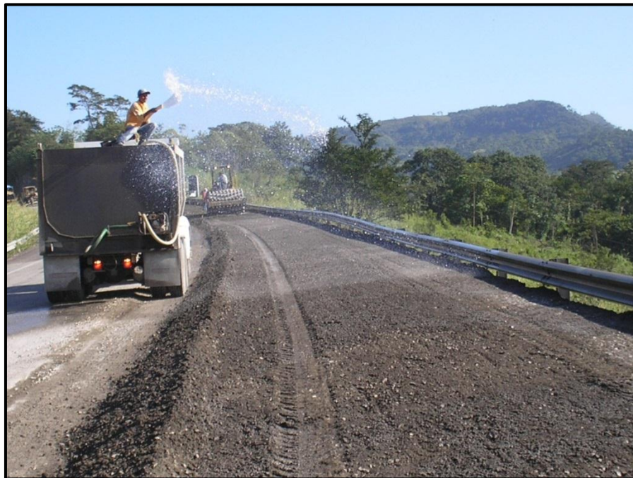
Figura 3.3.10.- Formación y compactación de base estabilizada
