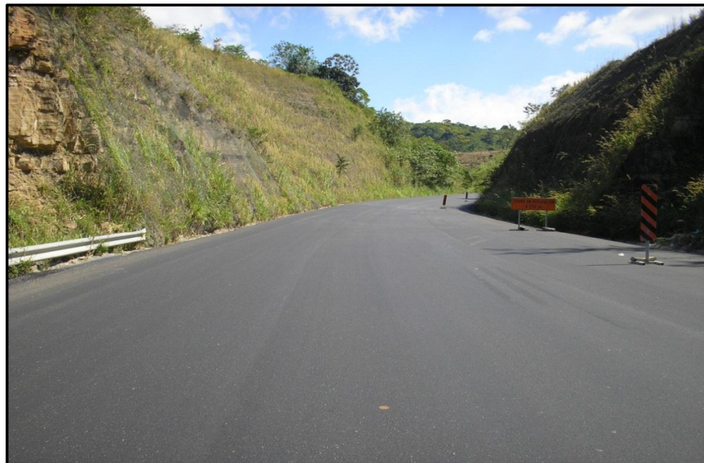
Figura 3.3.12.- Construcción de carpeta asfáltica sobre base estabilizada
