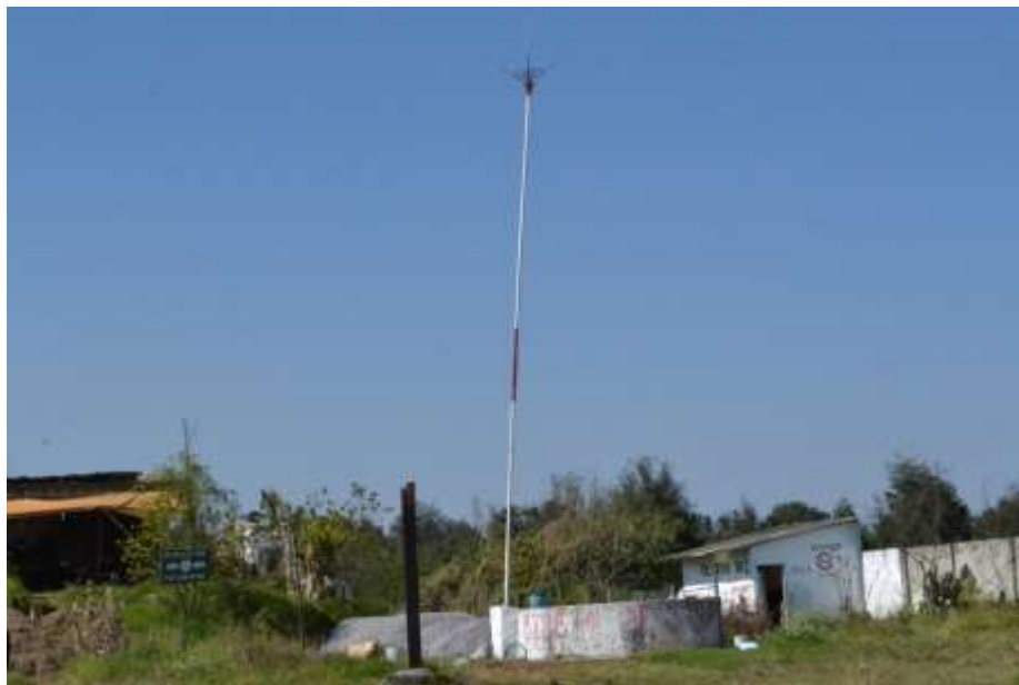
Imagen 49. Ejemplo de taller donde se observan polvorines, pileta de agua y pararrayos. Fotografía del autor.
