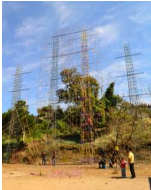
Imagen 84. Armado de castillos de hasta 25 metros de altura. Ofrendas a la virgen. Fotografía del autor.
