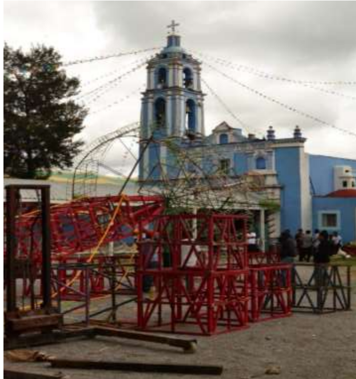
Imagen 95. Estructuras de castillos en proceso de construcción.
