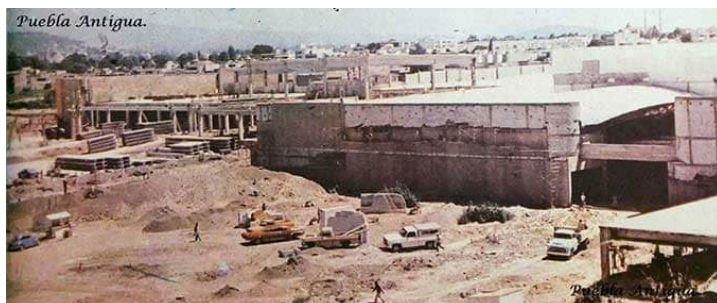
Construcción de la primera etapa de Plaza Dorada, septiembre de 1979
