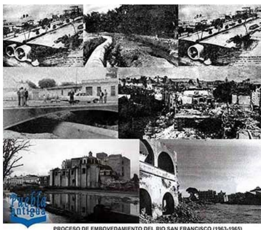
PROCESO DE EMBOVEDAMIENTO DEL RIO SAN FRANCISCO (1963-1965)
