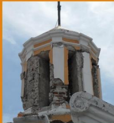
Grietas y fracturas en el cúpulin de la cúpula del transepto.
