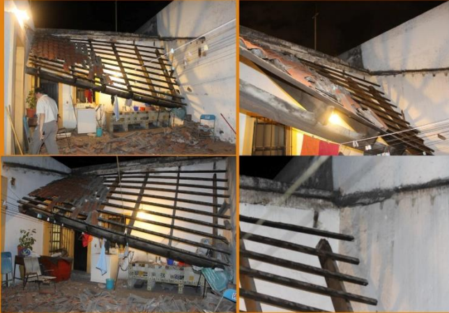
Colapso de cubierta de área de servicio
