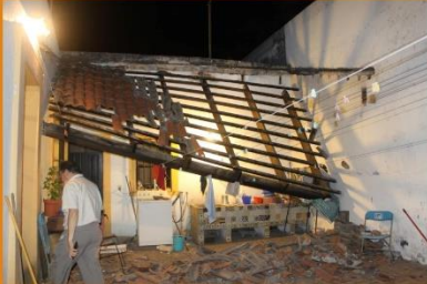
Colapso de cubierta en patio de servicio.
