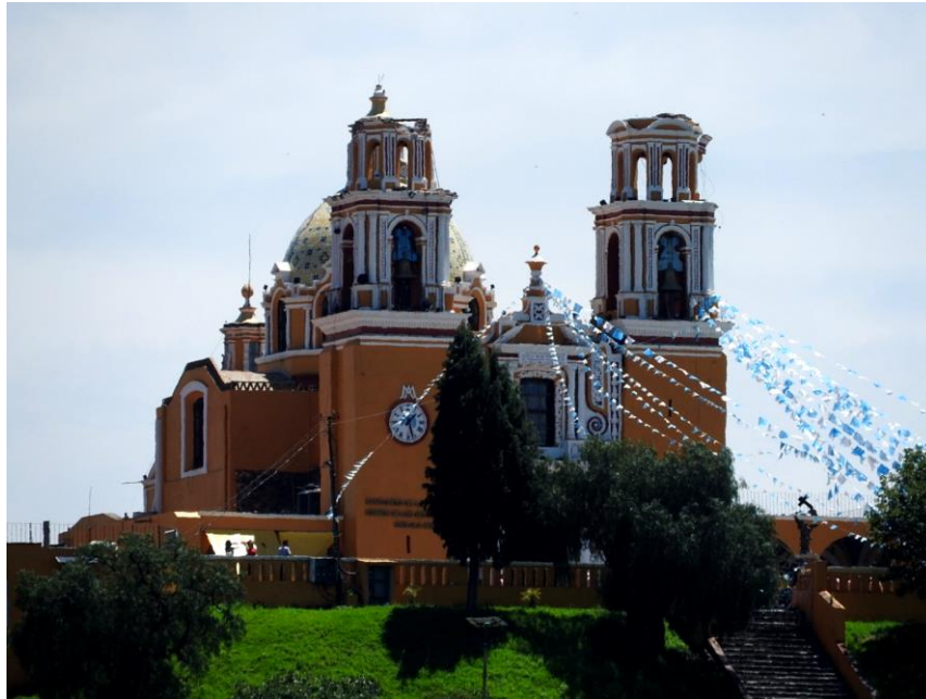
Rojas Flores, Myrna. 2017. Daños en las cúpulas del Santuario de la Virgen de Los Remedios. Fotografía. Recuperado de: http://municipiospuebla.mx/nota/2017-09-19/san-pedro-cholula/da%C3%B1os-en-5-templos-de-san-pedro-y-san-andr%C3%A9s-deja-el-sismo
