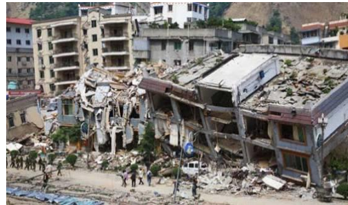
Figura 6: Efectos de un sismo en las construcciones
