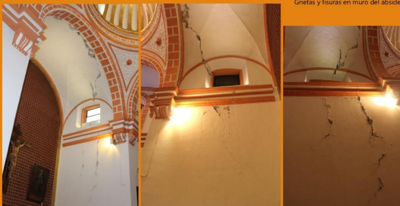
Grietas y fisuras en muro del ábside
