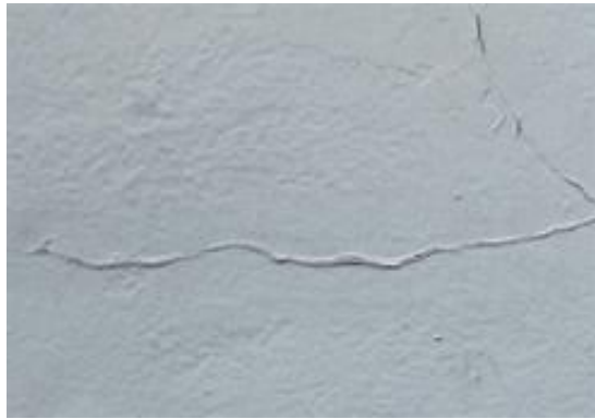
Fisuras en muros
