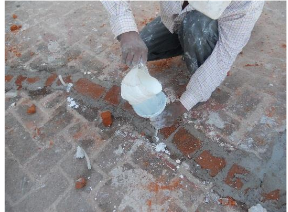
Ilustración 54 Inyección en la Grietas efectuadas al Templo durante su intervención; Fuente de la Fotografía: Maestra María del Carmen González
