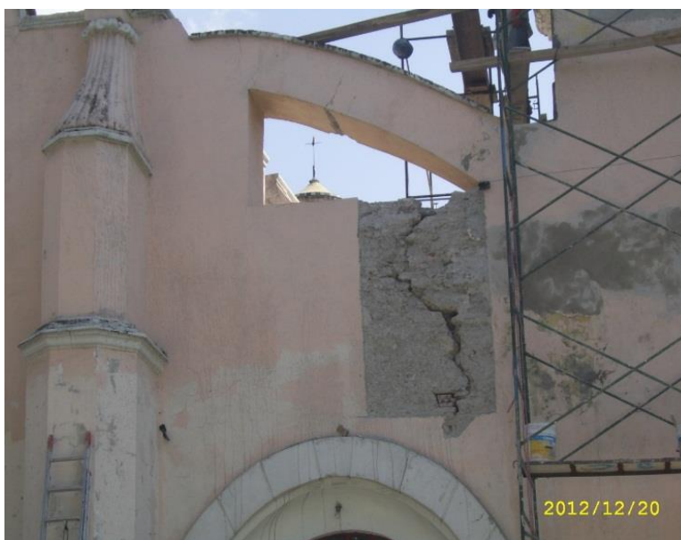
Ilustración 53 Trabajos de consolidación e inyección de grietas efectuadas al Templo; Fuente de la Fotografía: Maestra María del Carmen González Cedeño.
