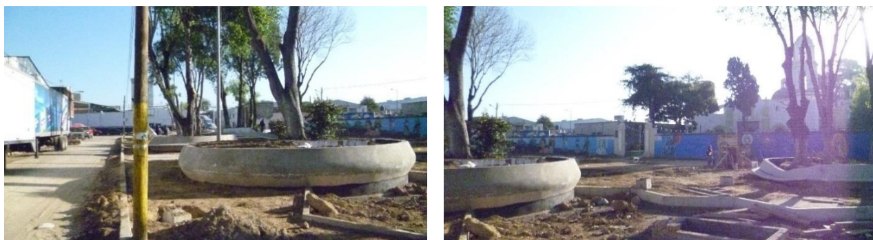
Ilustración 112 Vista de los trabajos en de las jardineras en el Parque; Fuente de la fotografía: Propias del Autor.
