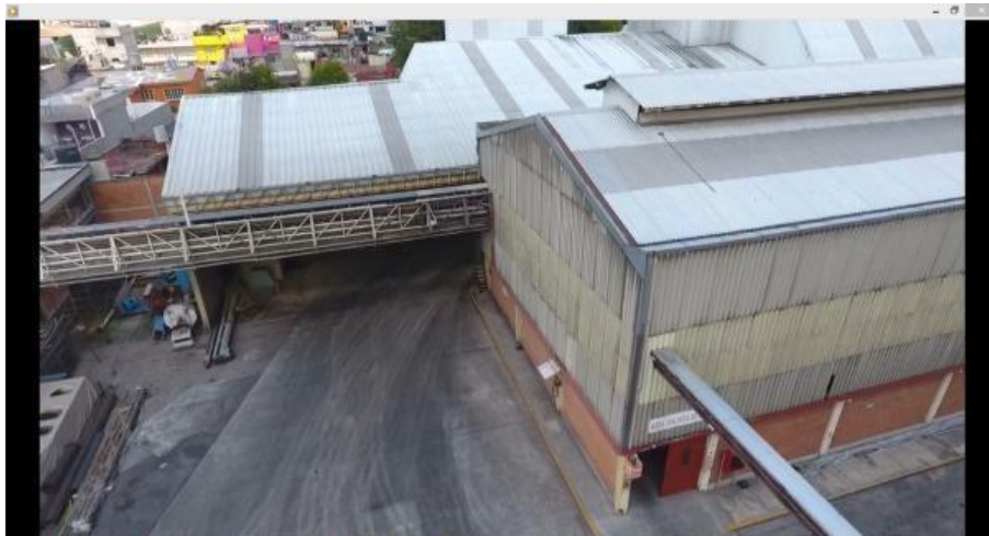
Ilustración 60 Vuelo de DRON sobre el Molino de Copra mostrando la forma de su cubierta y el sistema constructivo en la colocación de láminas de zinc. Fuente PAGA
