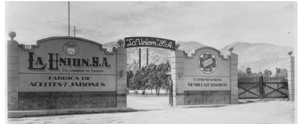
Ilustración 43 Compañía Industrial Jabonera "La unión", fachada. Recuperado el 9 de noviembre de 2022 de http://drsamuelbanda.blogspot.com/2014/04/imagenes-antiguas-de-la-comarca.html
