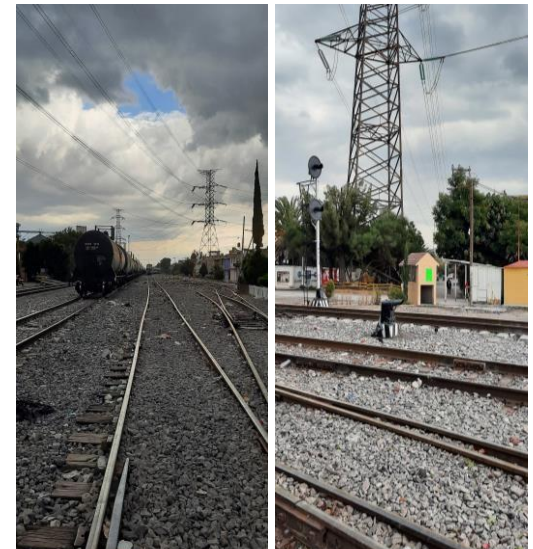
Ilustración 41 Perspectiva de las vías férreas FFCC México – Veracruz, que pasan junto a las naves Molino y Bodega de Copra. Tomada el 1 de octubre del 2021. Fuente: PAGA
