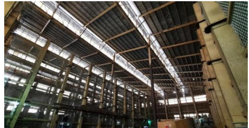
Ilustración 54 Interior de la nave Bodega de Copra, se observa la iluminación cenital por la forma de la cubierta “dientes de sierra”. Fuente: PAGA
