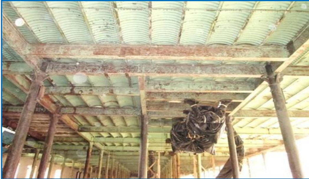
Ilustración 39 Interior de la nave de Telares en la ex fábrica "La Constancia Mexicana" (Antes de la intervención). Losa catalana hecha de lámina acanalada, columnas metálicas y vigería. Tomada el 24 de septiembre de 2013. Fuente: PAGA
