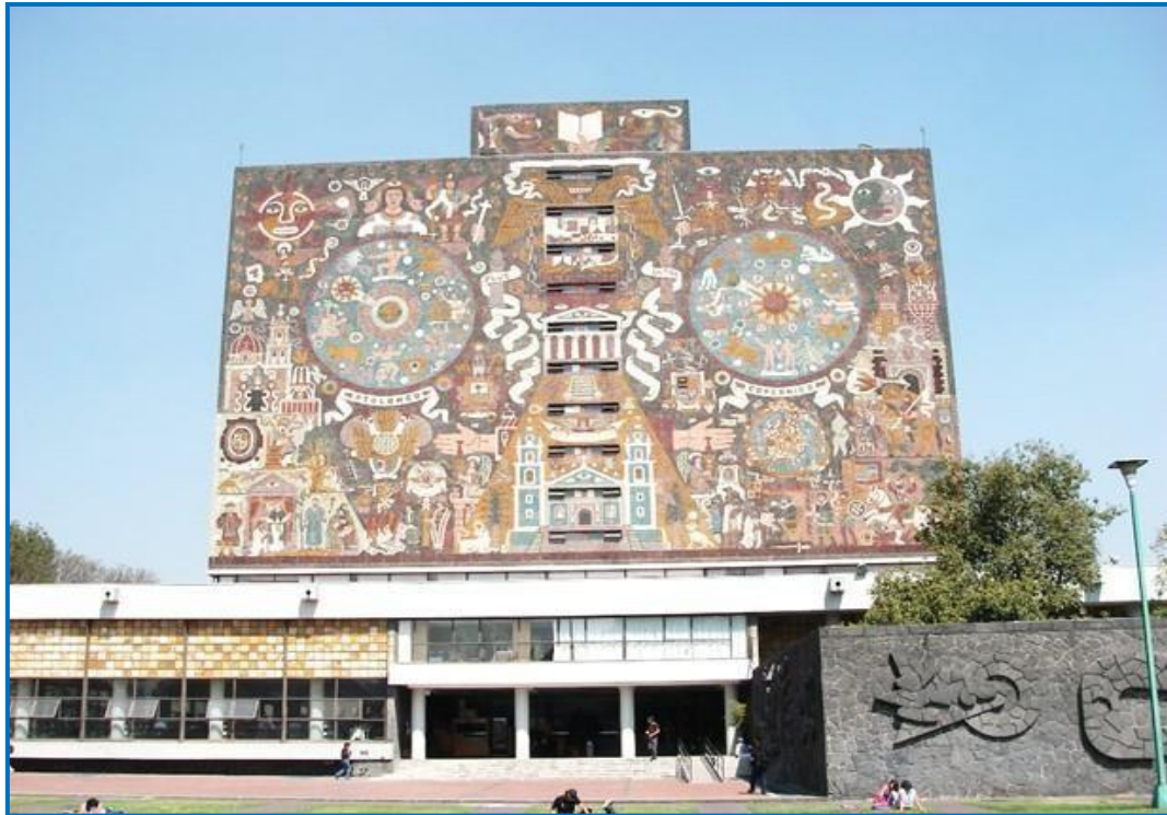
Ilustración 27 Fachada principal de la Biblioteca Central de la UNAM, el funcionalismo observado en sus columnas que soportan el edificio, los ventanales y las grandes dimensiones que dan lugar a espacios para murales que sirvieron de expresiones artísticas de personajes del siglo XX. Foto tomada el 18 de febrero de 2009. Fuente: PAGA
