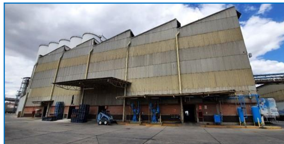
Ilustración 6 Fachada poniente Bodega de Copra dentro de la Fábrica de Jabón “La Corona”, en el municipio de Ecatepec de Morelos, Estado de México. Fuente: PAGA 02 de abril de 2021
