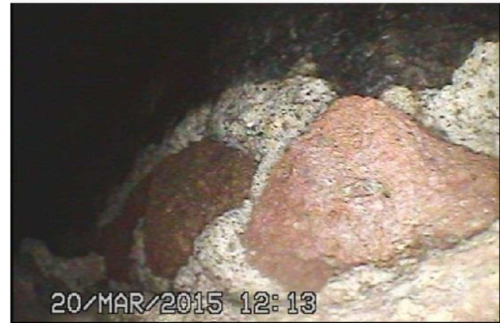
Imagen 54: Mampostería de tezontle en cimentación de “Las cárceles de la perpetua” en el estado de México 2015 imagen: Alan Gómez
