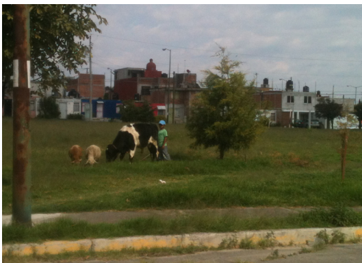
F.5.47. Centro de Barrio deshabitado y sin mantenimiento
