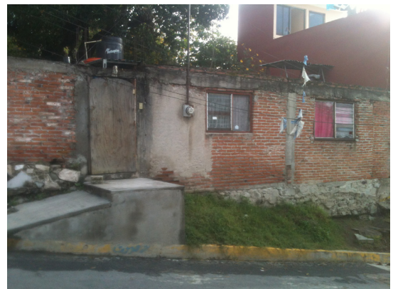
Foto 5.39. La calle es adoquinada pero las condiciones de las viviendas son precarias
