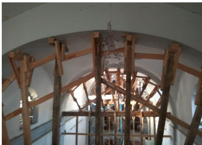
Fotografía 30 Aseguramiento en bóveda; Templo de Santa Inés del Barrio de Xanenetla. Gabriela Toledo G. (16-11-2017)
