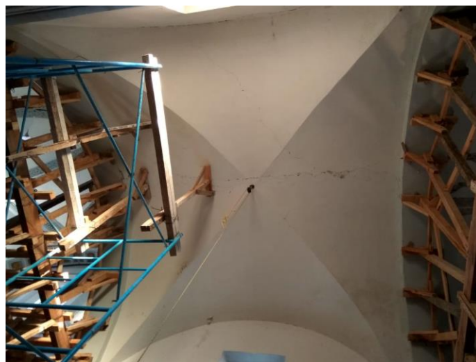
Fotografía 29 Aseguramiento en bóvedas y arcos; Templo de Santa Inés del Barrio de Xanenetla. Gabriela Toledo G. (16-11-2017)
