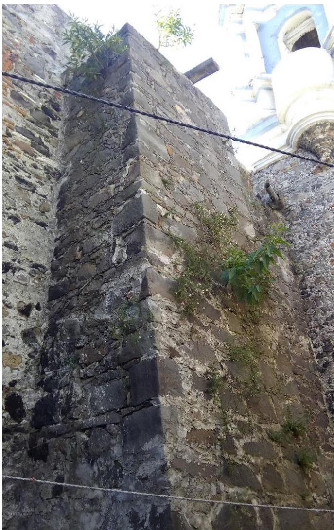
Fotografía 18 Muro de piedra, vegetación parásita; Templo de Santa Inés del Barrio de Xanenetla. Gabriela Toledo G. (Sep-2017)
