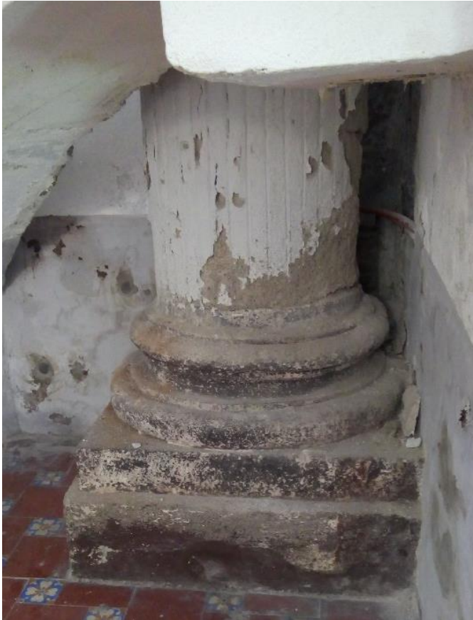
Fotografía 20 pulverización en materiales petreos. Templo de Santa Inés del Barrio de Xanenetla. Gabriela Toledo G. (2017)
