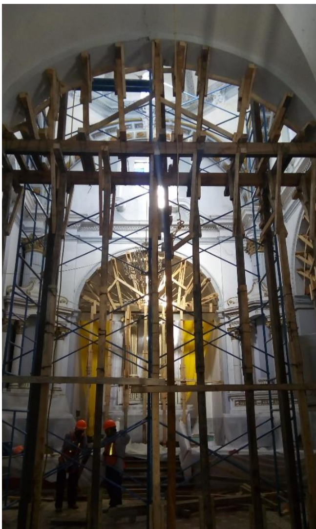
Fotografía 28 Aseguramiento; Templo de Santa Inés del Barrio de Xanenetla. Gabriela Toledo G. (16-11-2017)
