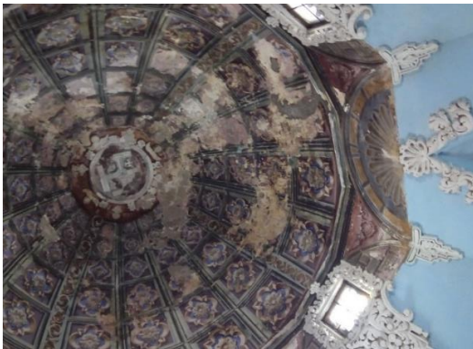
Fotografía 25 Humedad en la pintura mural del ochavo (sacristía) . Templo de Santa Inés del Barrio de Xanenetla. Gabriela Toledo G. (2018)
