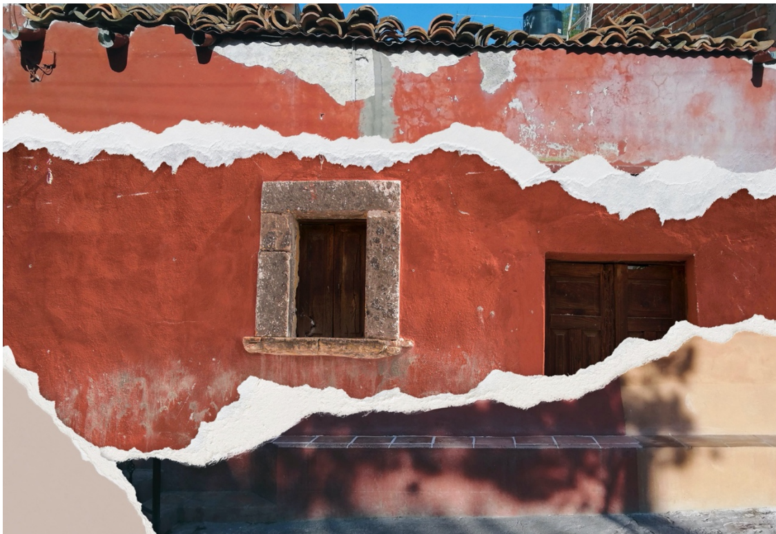
Ilustración 9 - Las arquitecturas vernáculas tradicionales de San Miguel de Allende se ubican en los perímetros de amortiguamiento de la zona Patrimonio Mundial o en colindancia inmediata, y se caracterizan por su baja altura y su austeridad constructiva. Algunas tienen asientos de piedra adosados a sus fachadas, conocidos popularmente como “poyitos” y que desdibujan los límites del espacio privado y el comunitario. Resaltamos que la vivienda al centro de esta imagen fue derruida por completo en el transcurso de la investigación. (Composición fotográfica: elaboración propia).
