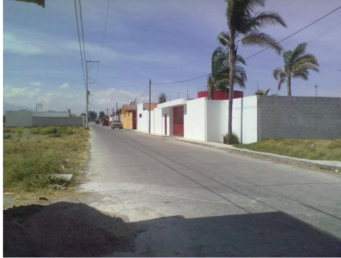
Imagen.14. Construcción nueva de casa habitación en la comunidad de Chipilo. Dueñas (2013).
