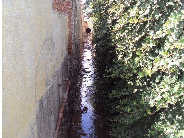
Imag.12. Predios divididos por Zanjas de drenaje. Dueñas (2013)
