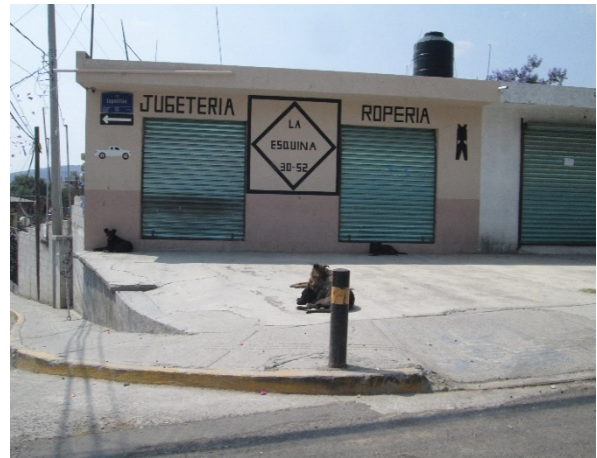
Ilustración 43 Banquetas, guarniciones, guarda peatón en la Av. Principal, i. Soriano 2022
