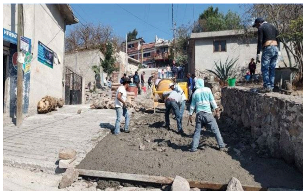
Ilustración 64 Comunidad autoconstruyendo vialidades en la ZC, marzo 2023
