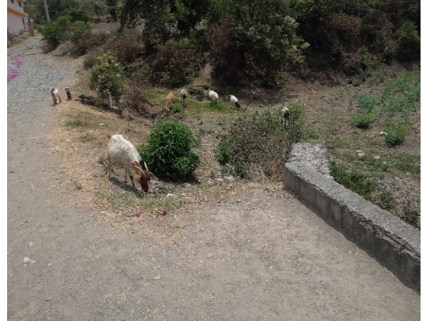
Ilustración 41 Puente sin barreras constructivas a la barranca, i. Soriano 2022
