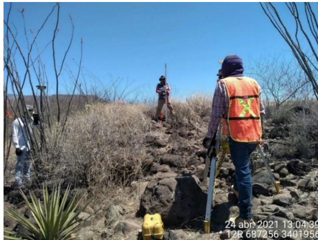
Imagen 80. Colocación de banco de nivel en el estado de Sonora. Fuente: Propia.
