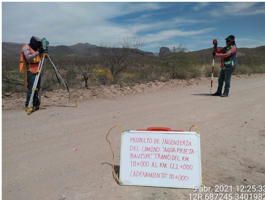
Imagen 78. Fotografía de levantamiento topográfico en camino existente. Fuente: Propia.
