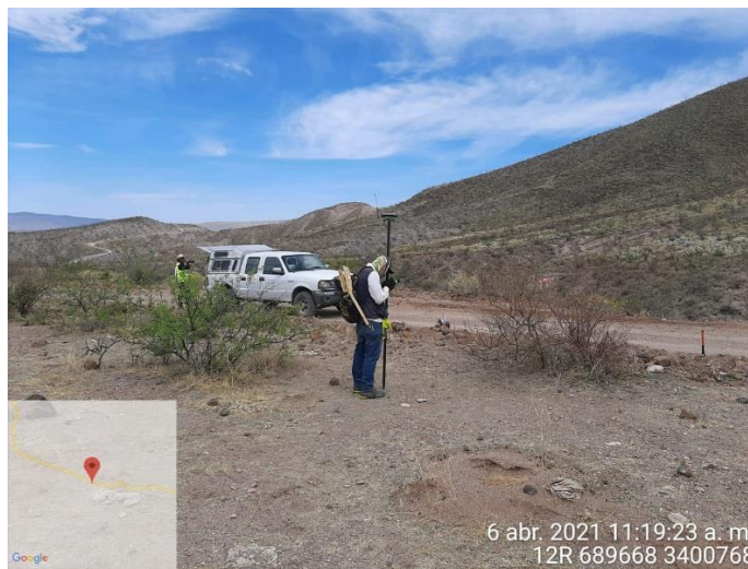
Imagen 83. Replanteo de referencia de punto geométrico. Fuente: Propia.
