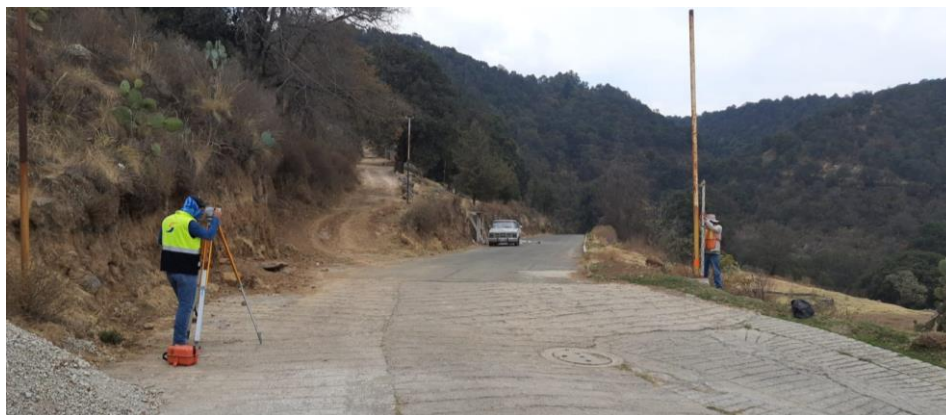
Imagen 30. Nivelación realizada en el Estado de México. Fuente: Propia.
