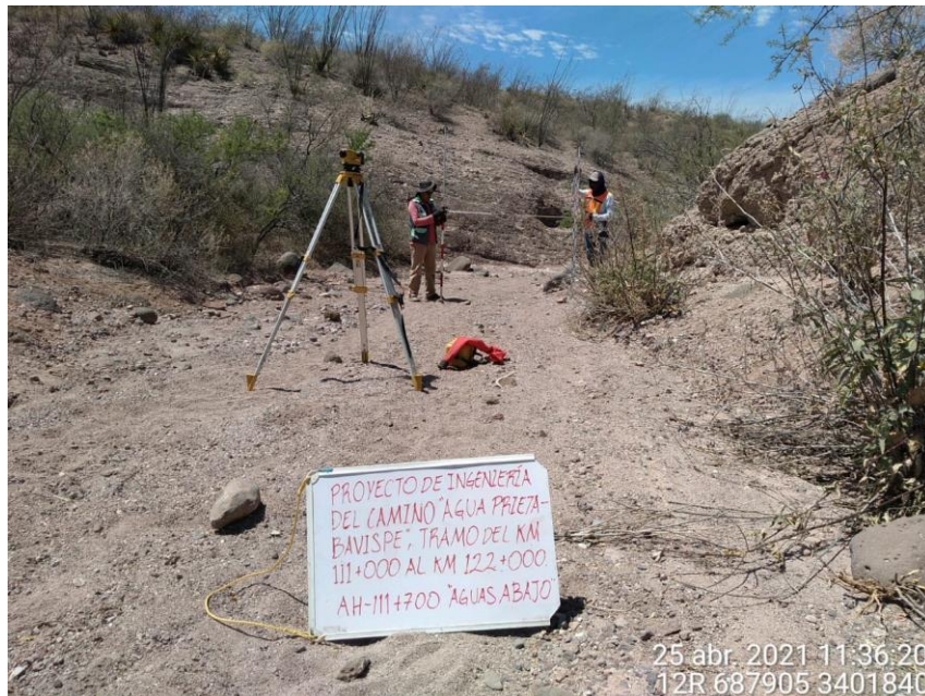
Imagen 86. Seccionamiento de escurrimiento hidráulico existente. Fuente: Propia.
