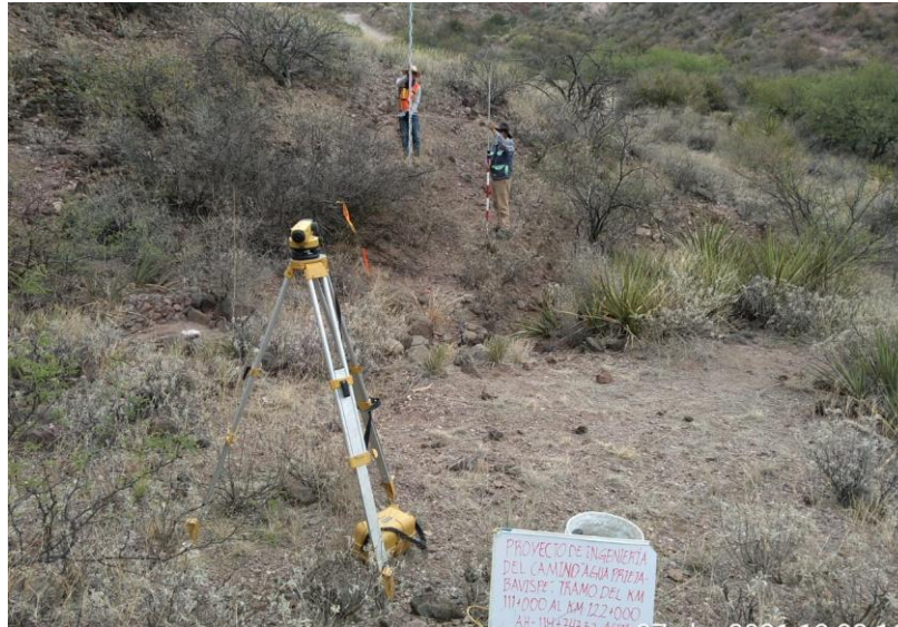
Imagen 55. Seccionamiento de escurrimiento hidrológico existente. Fuente: Propia
