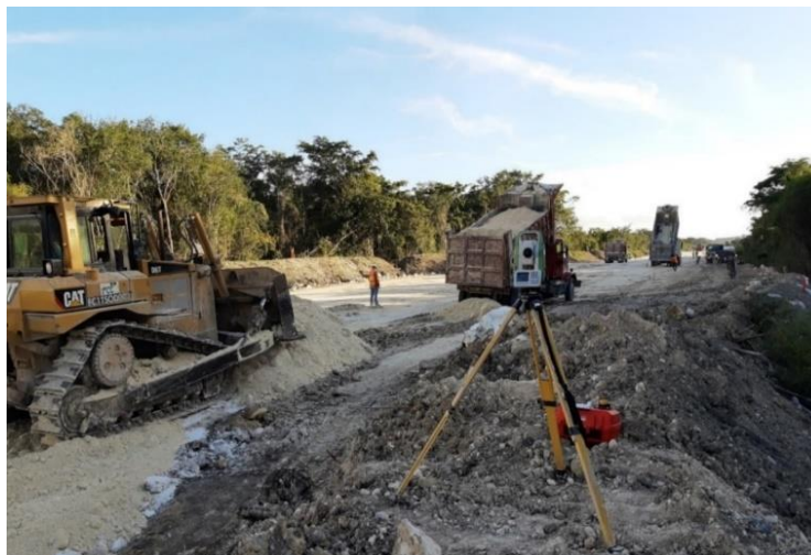
Imagen 39. Colocación de referencias de trazo en tramo 2 del tren maya, Campeche. Fuente: Propia.
