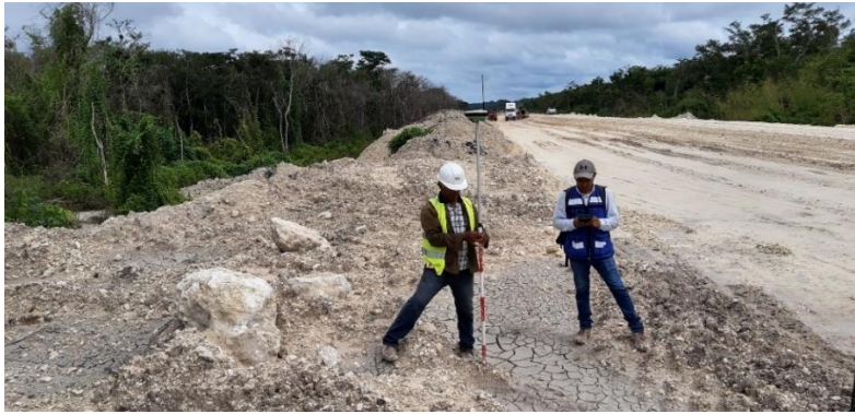
Imagen 38. Trabajos topográficos realizados con GPS RTK en Campeche. Fuente: Propia.
