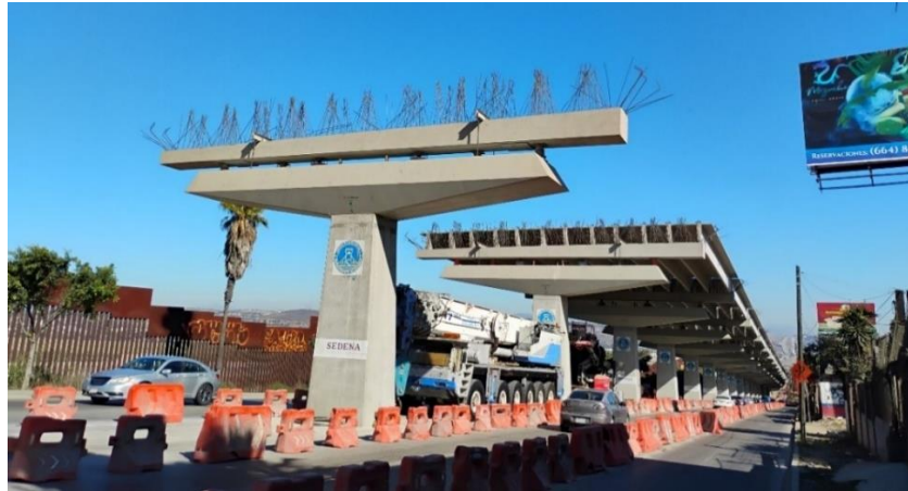
Imagen 29. Viaducto en construcción de playas de Tijuana a la garita de Otay. Fuente: Propia.
