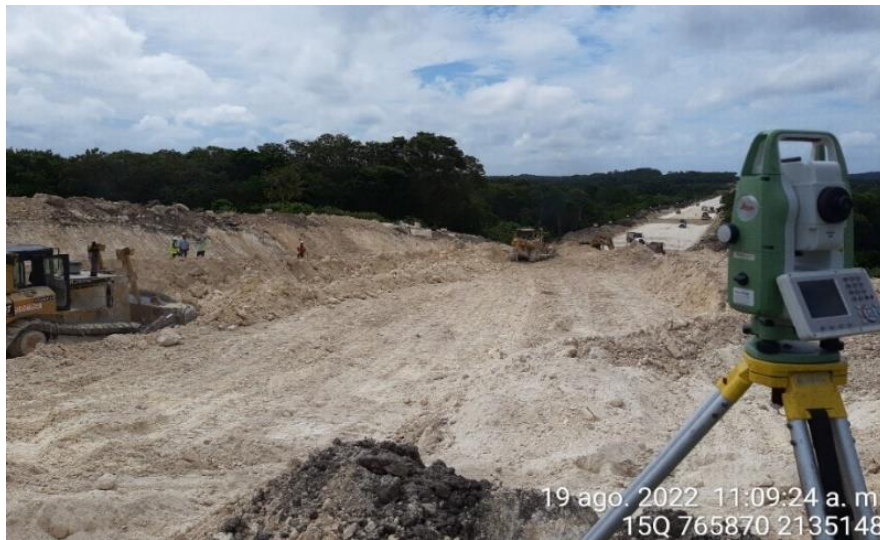
Imagen 34. Realización de trabajos topográficos en tramo 2 del tren maya, Campeche. Fuente: Propia.
