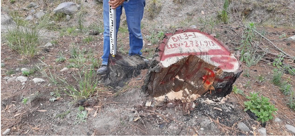
Imagen 51. Colocación de banco de nivel para proyecto en el estado de Tlaxcala. Fuente: Propia.
