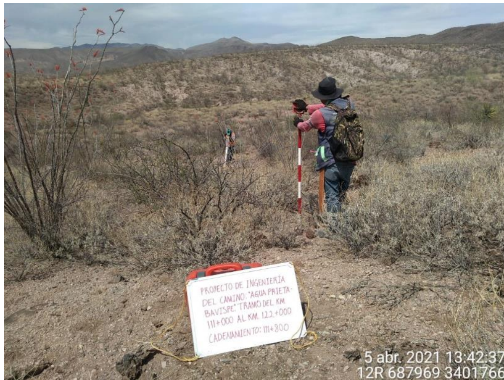
Imagen 60. Realización de trabajos topográficos en el edo. De Sonora. Fuente: Propia.
