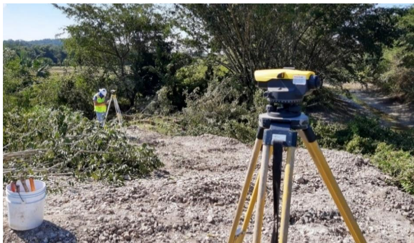
Imagen 46. Realización de nivelación en tramo 2 del tren maya, Campeche. Fuente: Propia.
