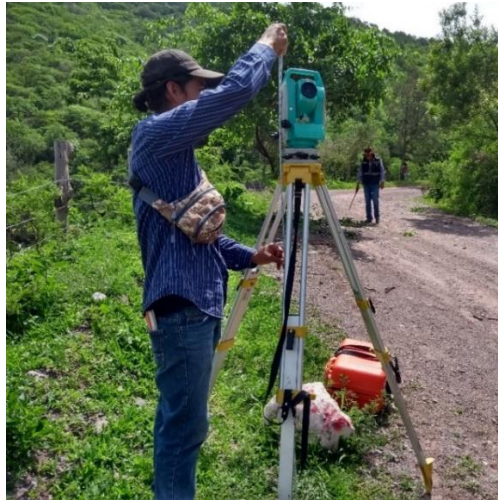
Imagen 35. Realización de trabajos topográficos en el estado de Guerrero. Fuente: Propia.
