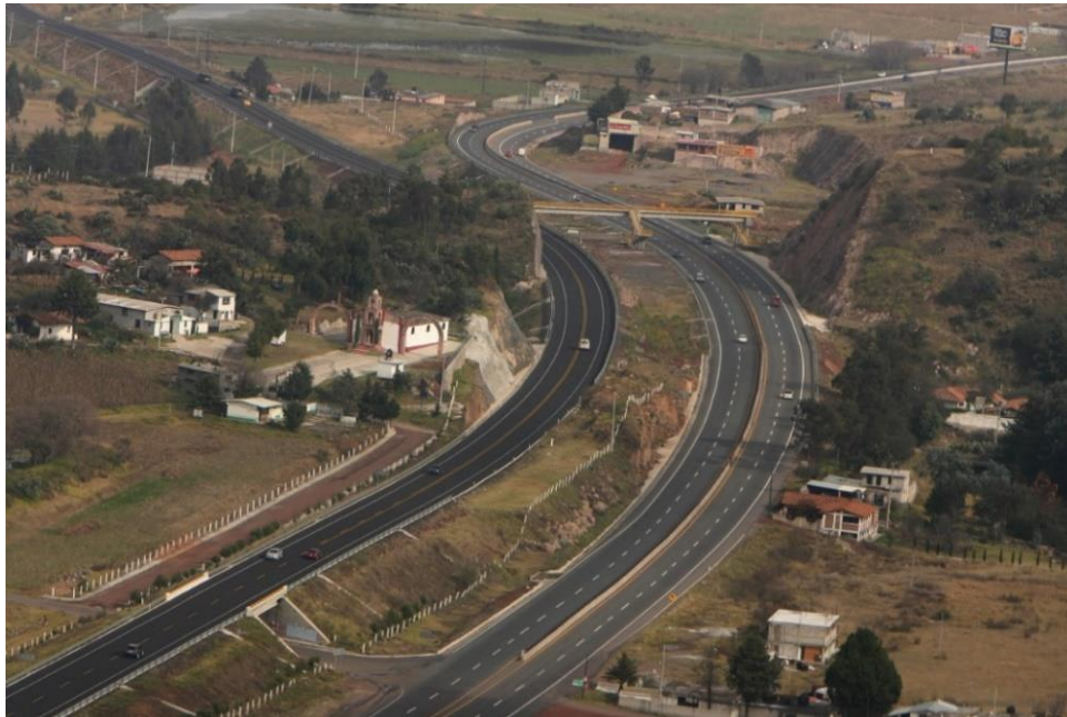
Imagen 28. Carretera en el Estado de México. Fuente: https://www.gob.mx/sct/galerias/entrega-sct-12-carreteras-para-aumentar-la-competitividad-y-conectividad-en-10-estados-del-pais#carousel-custom
