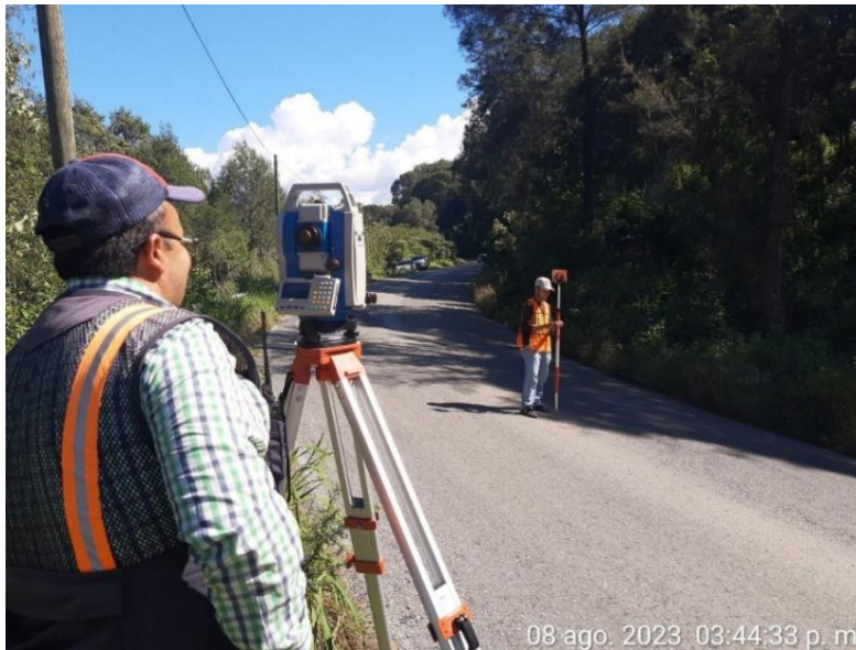
Imagen 44. Seccionamiento sobre carpeta existente. Fuente: Propia.
