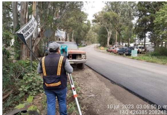
Imagen 40. Colocación de vértices de apoyo en campo. Fuente: Propia.
