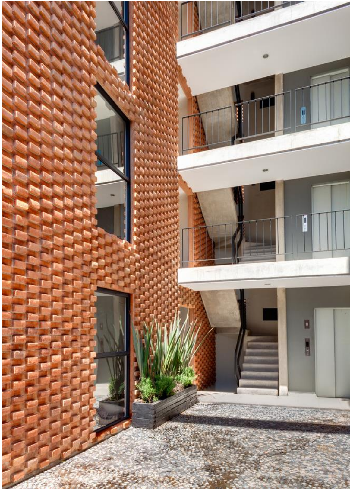
Imagen 37: Vista desde uno de los patios interiores de la vivienda, observando el volumen y la textura que genera el tabique de barro rojo. Ciudad de México. Fuente: ArchDaily Fotografía: Rafael Gamo.
