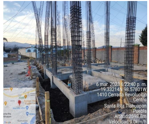
Zapatas aisladas por medio de trabes de liga
