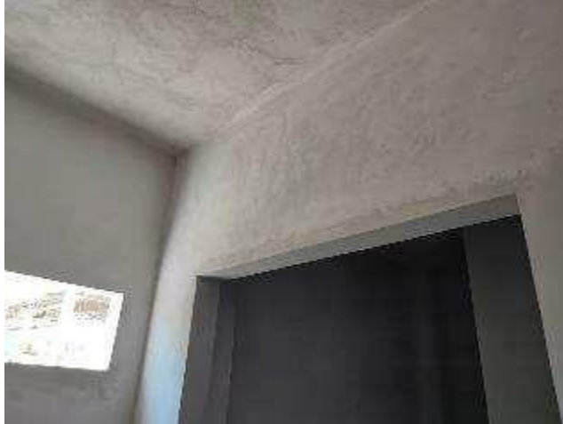
Repellado y aplanado fino en interiores
