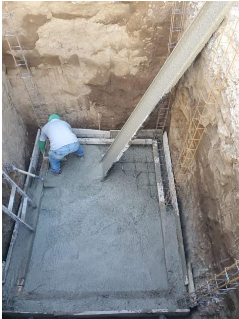
Construcción de la cisterna de concreto
