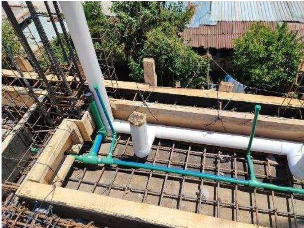
Armado de losa 1er nivel
