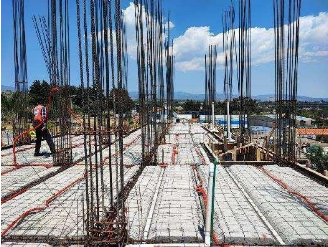
Armado de losa 1er. Nivel y colocación de poliducto de \frac{3}{4} para instalación eléctrica
