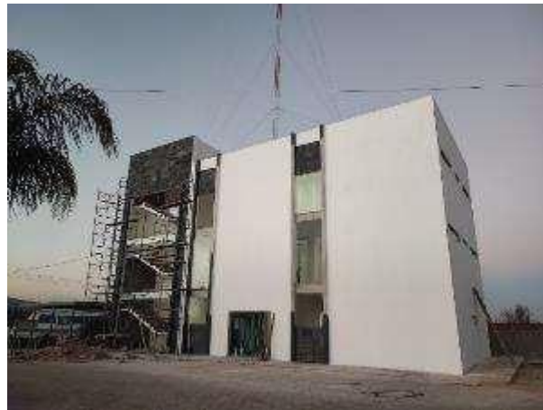
Acabado en muros exteriores.
