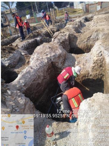
Compactación para base de zapata
