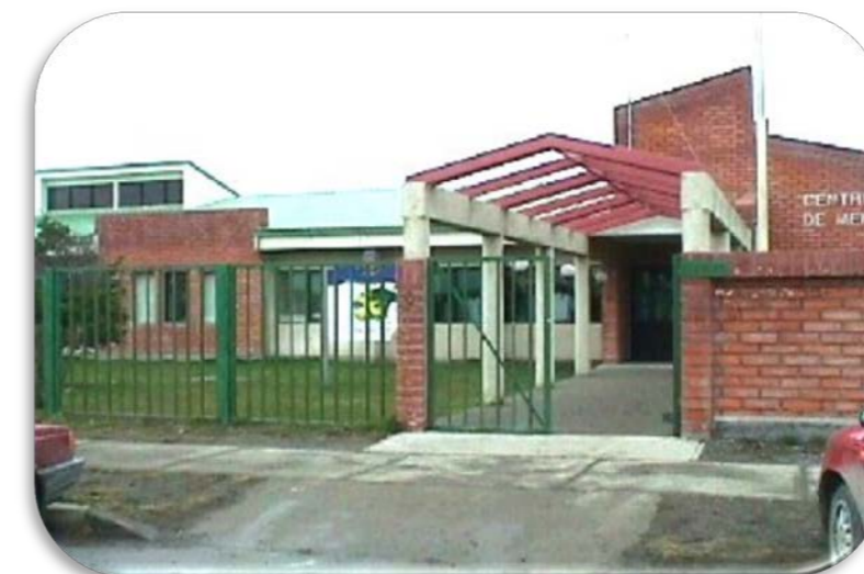
Entrada Principal al Centro
