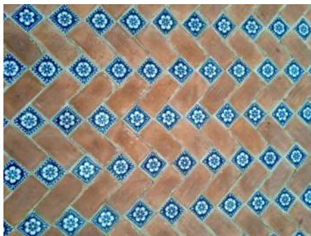
Figura 3.27: Teselación como decorado en un edificio de la ciudad de Puebla, México.
