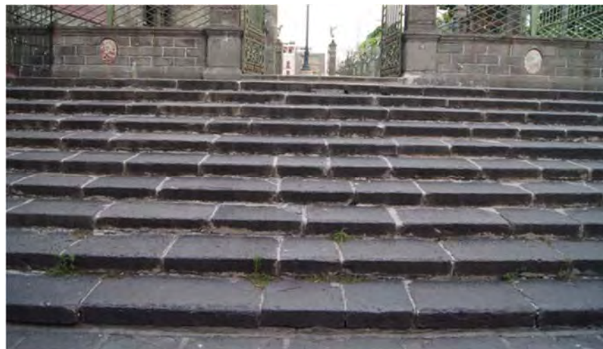
Imagen 4.25 Acceso exterior A.
