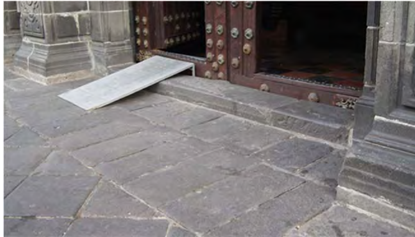
Imagen 4.38 Acceso por puerta de San Cristóbal, vista desde el exterior.
