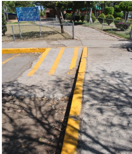
Figura 10 Rampa improvisada. Antes de remodelación (Pérez, G. 2014)
