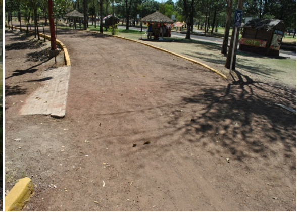
Figura 12 Rampa, Anterior. Muestra claramente los cambios de nivel y condiciones de rampa que en la actualidad se conservan (Pérez, G. 2016)
