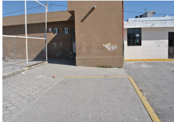
Figura 25 Rampa frente a Inspección. Costado salones de clases (Pérez, G. 2014)
