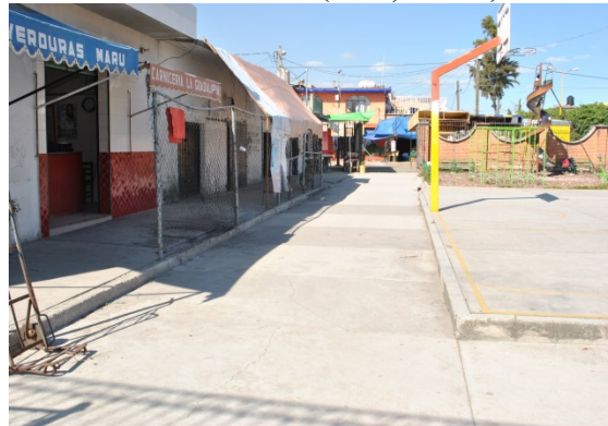
Figura 27 Rampa por autoconstrucción, acceso a un local comercial (Pérez, G. 2014)
