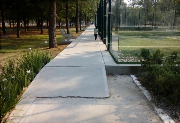
Figura 11 Andador de acceso a Canchas de tenis. Rampa si Barandal (Pérez, G. 2016)
