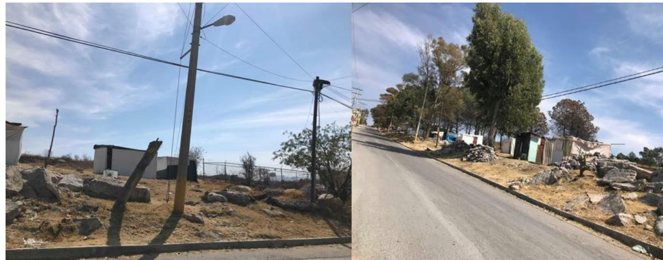
Ilustración 81. Vista Frontal del Predio y Vista del terreno aledaño al este desde la Av. Coyoacán. Fotografía: Báez, Betanzos, Fernández (ene 2017).
