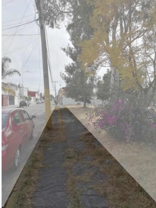
Imagen 43. Banqueta. Calle Río Salado (Fuente: Fotografía propia).
