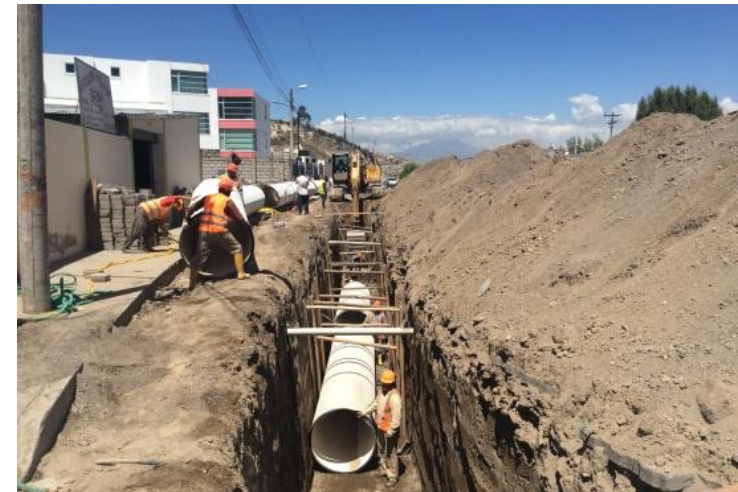
Fotografía 73, del cambio de tubería para el desazolve de las alcantarillas
