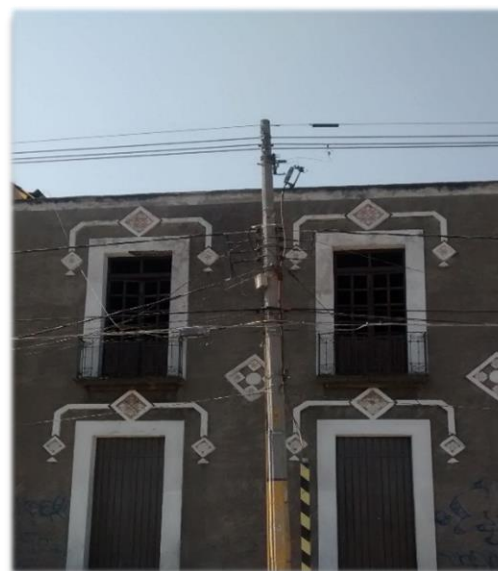
Fotografía 35, de los postes de luz actuales en la 7 oriente
