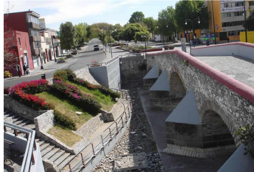
Fotografía 77, de la perspectiva de la 3 oriente desde el Boulevard.
