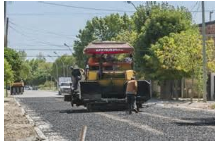
Fotografía 59 y 60 ejemplos de pavimentación
