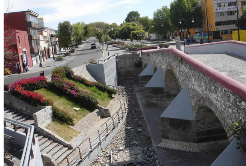
Fotografía 62, ejemplo del puente de ovando sin cables
