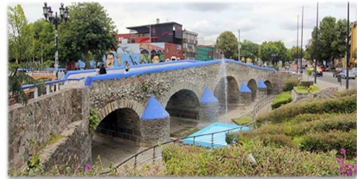
Fotografía 49, restauración que se le hizo al puente Ovando en 2010
