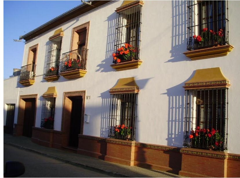
Fachada 63, ejemplo de remodelación y recuperación de fachadas
