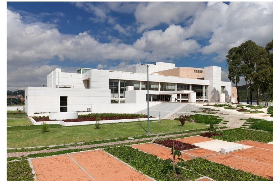
Fachada Suroeste de Centro cultural Julio Mario Santo
