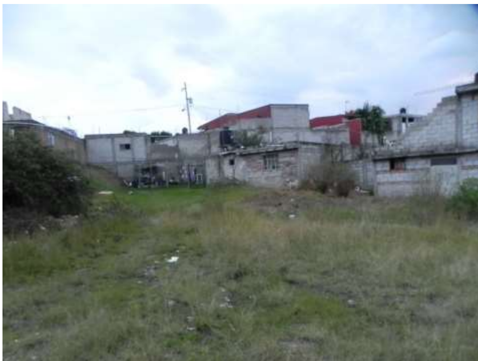
Imagen 47. Ramírez Flores, J. (2015). Viviendas ubicadas al margen del cauce, entre las calles Fernando Arruti y Ricardo de Alconedo. [Fotografía]. Puebla: Colonia Francisco Javier Clavijero.
