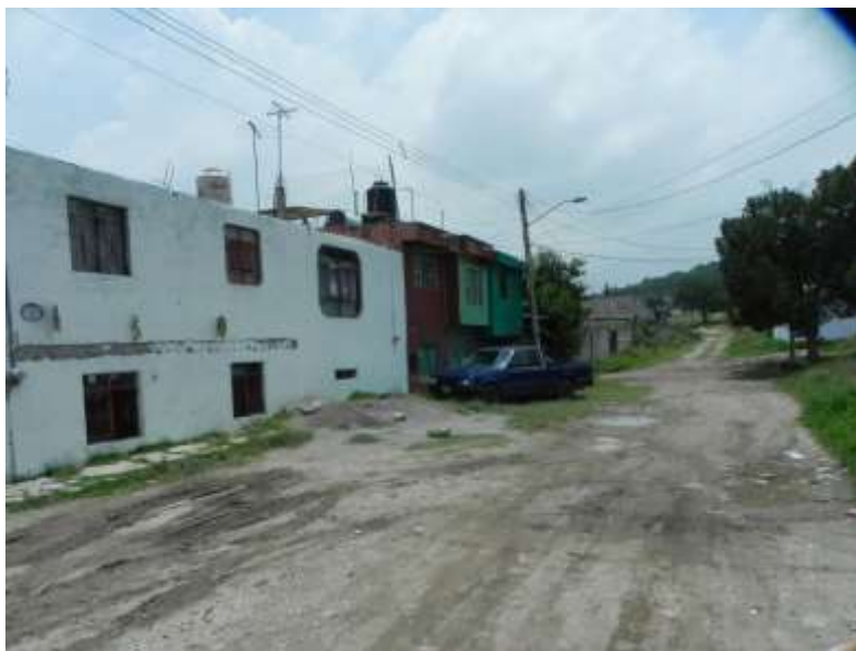
Imagen 60. Ramírez Flores, J. (2015). El nivel de la calle ha ido en aumento por almacenamiento de partículas finas de suelo transportado a consecuencia de la erosión. [Fotografía]. Puebla: Colonia Francisco Javier Clavijero.
