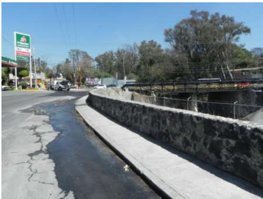
Imagen 26. Ramírez Flores, J. (2015). Primer punto de riesgo a inundación -respecto a aguas arriba-. El desnivel de la calle Juan Pablo II canaliza el agua hacia ambos lados de ésta, sin embargo, del lado de La Colonia La Hacienda y con la barrera que representa el murete ocasiona anegación del agua. [Fotografía]. Puebla: Colonia la Hacienda.
