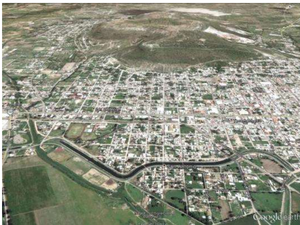
Imagen 21. Google Earth. (2013). Al centro el Barrio de San Antonio, bordeado por el canal de riego –del sistema de riego 30 Tecamachalco–, y la carretera federal a Tehuacán. [Fotografía Satelital]. Recuperado de http://www.google.com
