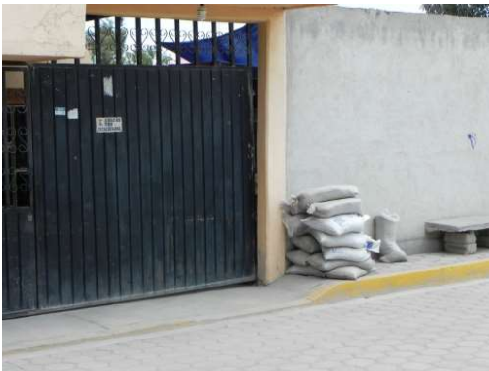
Imagen 22. Ramírez Flores, J. (2011). Costales de arena para evitar inundaciones dentro de la vivienda -ubicada en la 19 sur entre 13 y 15 poniente en el Barrio de San Antonio. [Fotografía]. Puebla: Barrio de San Antonio.
