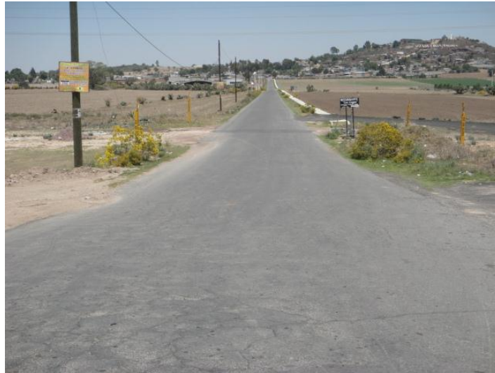
Cruce del DDV con camino vecinal "Palo Hueco".
