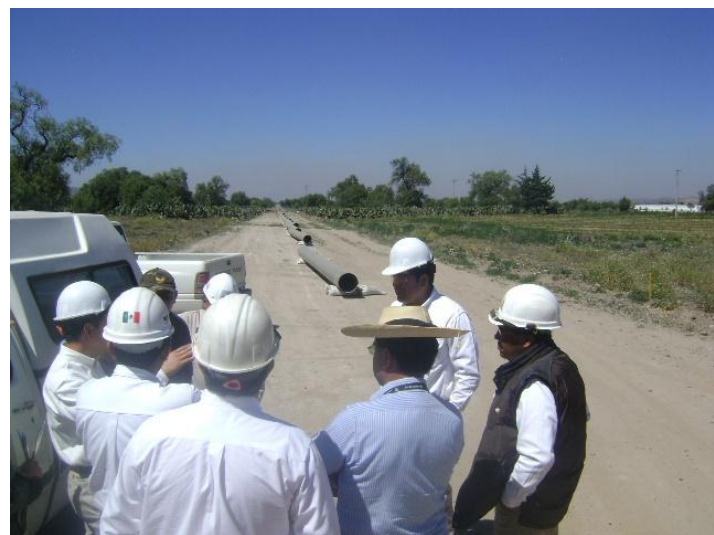
Suspensión parcial de los trabajos.
