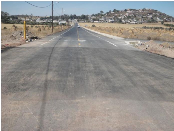
Construcción de cruzamiento a cielo abierto y reacondicionamiento de camino vecinal.
