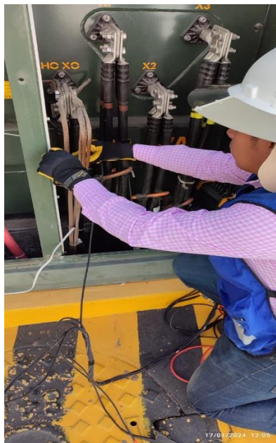
Fig 30 Instalación de pinzas amperimétricas
