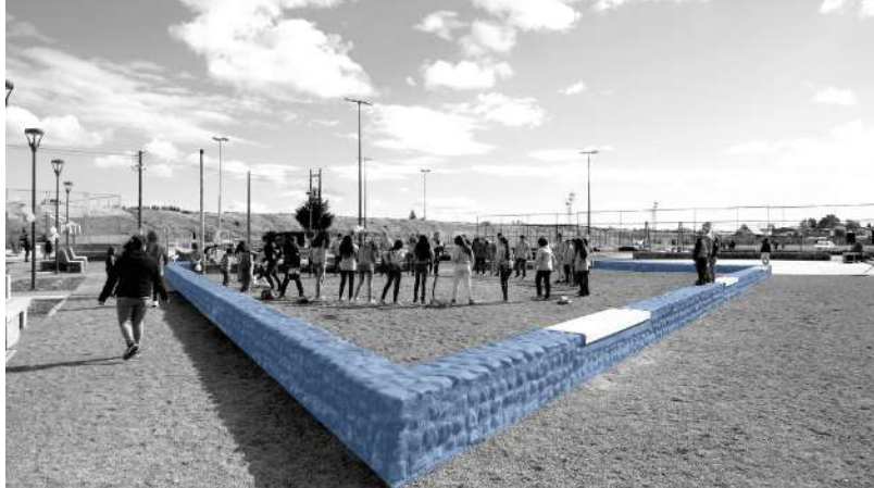
Image No. 30,. Cancha de usos múltiples. Elaboración propia
