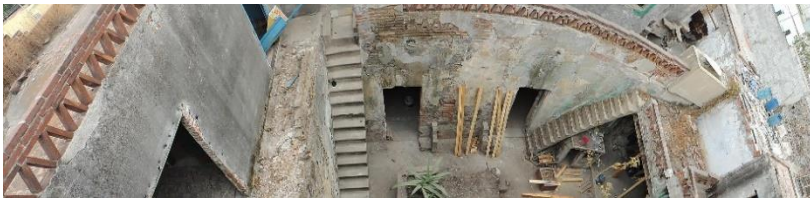
Foto 16: Se observan las escaleras que llevan a la planta alta y terraza, respectivamente. JMA-2013
