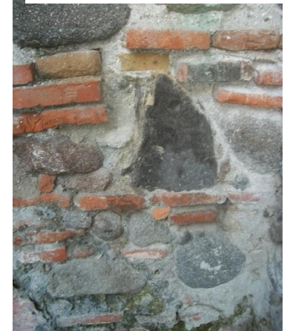
Foto 21: de muro en planta baja de un caso de estudio: se observa tabique y el mortero de cal de los muros. Fecha: 03/2015 JSQ
