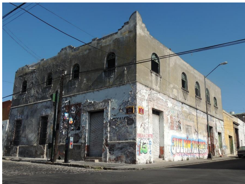
Foto 3: Fachada Edificio 14 Sur No. 507 Barrio de Analco Fecha: 19022013. JMA
