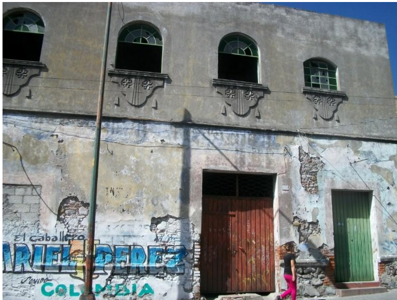
Foto 19: Fachada Principal, calle 14 Sur. Fecha: 01032015 JSQ
