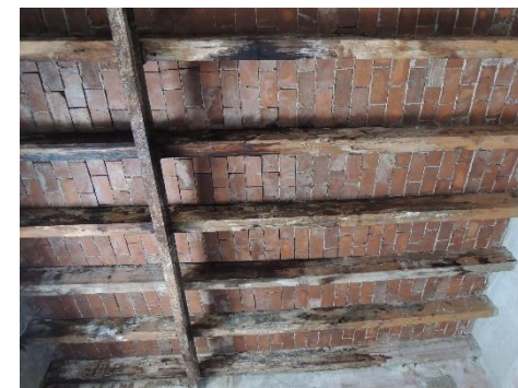
Foto 22: Se muestran vigas de madera en construcción original y viga de acero en posterior intervención Fecha: 032015 JSQ
