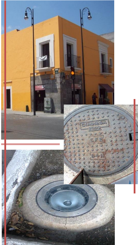
IMAGEN 5 ALUMBRADO, arriba POSTES SIN CABLES, esquina de la 14 oriente y 2 norte, al centro REGISTRO DE CFE, abajo LUMINARIA DE JARDÍN, PARQUE DE SAN JOSÉ, ILUMINACIÓN DECORATIVA, tomada por RKHR, junio 2013.
