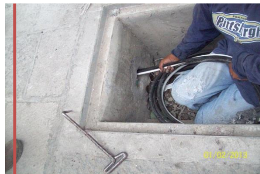
IMAGEN 4 TENDIDO DE CABLES PARA ELECTRIFICACION DOMICILIARIA EN DUCTO SUBTERRANEO, calle 2 norte n° 1410 JMM, tomada por RKHR, junio 2013.
