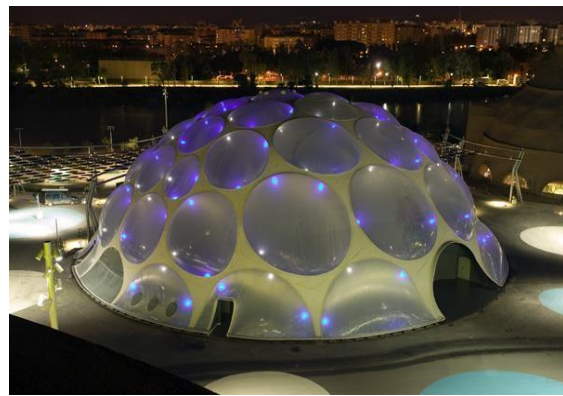
Piel paramétrica. De materialidad ETFE, alta tecnología tridimensional. cloud 9. En la Fig 2.2.6“Pabellón de la sed”. Burbuja polimérica.
