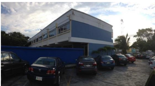
Fig. 4.1.b. posición poniente y Fig. 4.1.c. Posición norte. Este es el Estado actual del edificio de arquitectura de la Universidad Cristóbal Colón.
