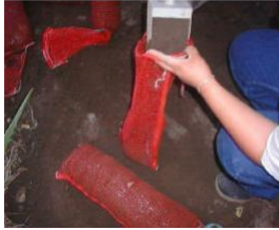
Relleno de las arpillas. EDLFL, 2001.
