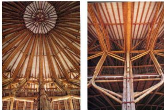
Figura 7 Detalle de las columnas y traves del Pabellón ZERI (Salaz, 2006)
