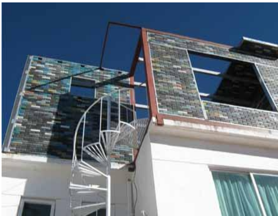
Imagen 10. Edificación con bloques Cero's (Esnavi Constructora, 2018).
