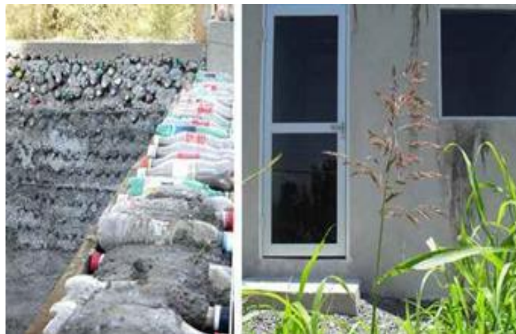
Imagen 1. Construcción con muros a base de PET. CIDETEQ, 2014
