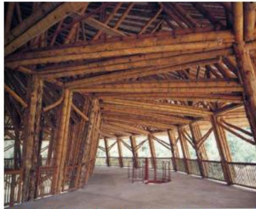
Figura 8 Nudos de un pasillo del Pabellón ZERI (Salaz, 2006)
