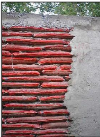
Imagen: Aplanado del muro
