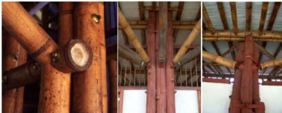
Figura 15 Uniones viga-columna (Salaz, 2006)
