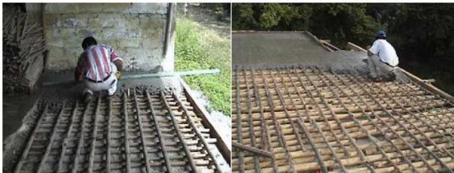
Figura 2 Utilización del bambú como acero de refuerzo (Bejarano 2002)
