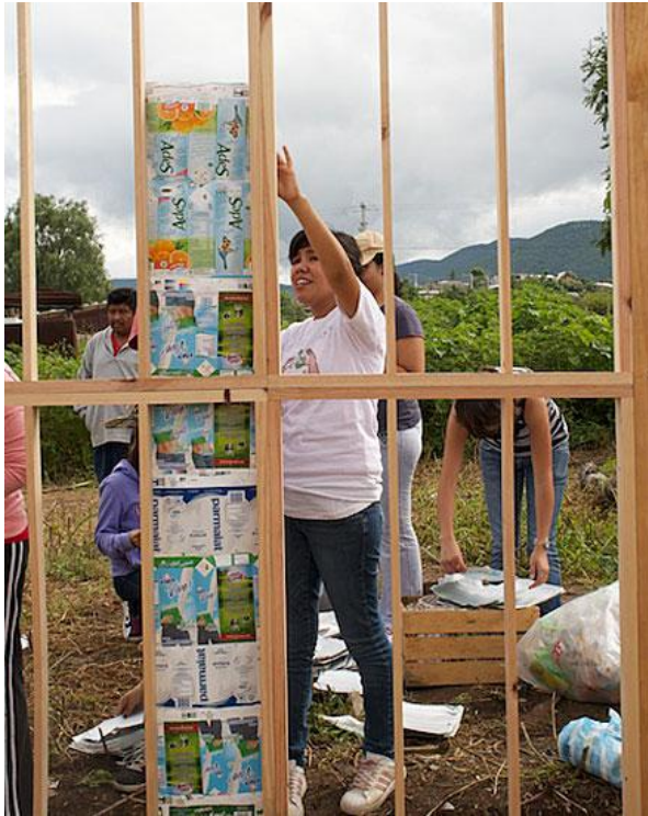
Imagen 12. Jovenes ayudando recubrir los muros con tetrapak. (Letón, 2017)
