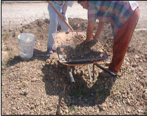
Se eliminan las piedras de tamaño más grande que un ancho del pulgar. EDLFL 2001
