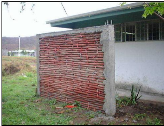
Imagen: Vista del muro terminado sin aplanar.
