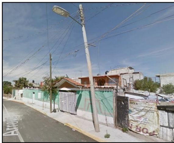
Poste de CFE. Imagen de Google Street View, 2017
