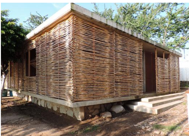
Imagen 14. Edificación de muros de bahareque. (Franco, 2015)
