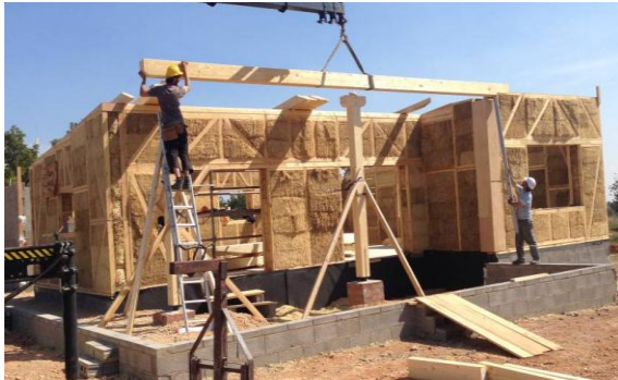
Imagen 13. Edificación de muros de paja. (Letón, 2017)
