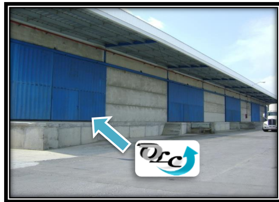
Imagen No. 8. Instalaciones de la OLC
