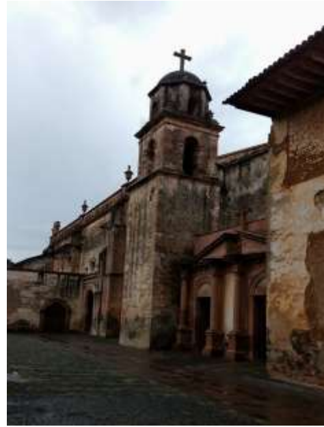
Ilustración 20. Templo del Sagrario, Pátzcuaro Michoacán, inmueble en pésimas condiciones de conservación. Foto tomada por Arq. Jesús Saucedo León 2017
