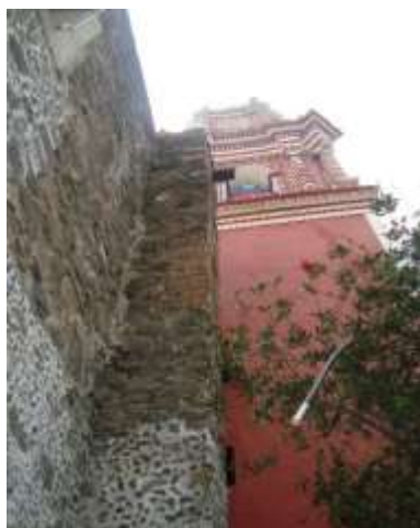
Ilustración 15. Vista exterior de muro y contrafuerte del Templo de Santa María Tonatzintla, San Andrés Cholula. Foto tomada por Arq. Jesús Saucedo León 2012
