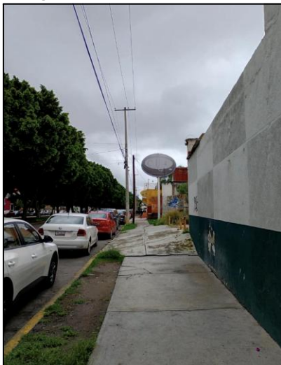
Fotografía 13. “Estado actual de la infraestructura localizada”. Foto propia: Hernández A. y Tinajero E. (2025)
