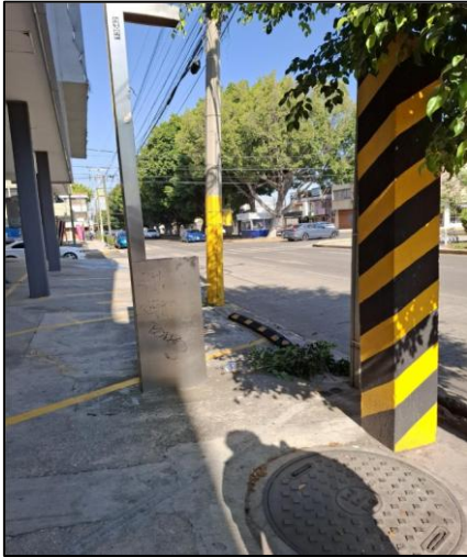
Fotografía 15. “Estado actual de la infraestructura localizada”. Foto propia: Hernández A. y Tinajero E. (2025)
