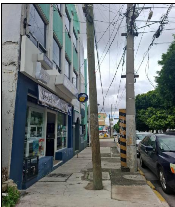
Fotografía 30. “Servicios básicos obstruyendo la banqueta” . Foto propia. Hernández A y Tinajero E. (2024)
