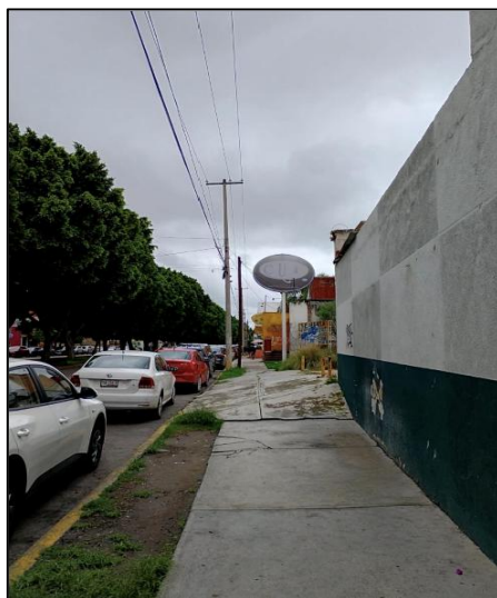
Fotografía 12. “Estado actual de la infraestructura localizada”. Foto propia: Hernández A. y Tinajero E. (2025)
