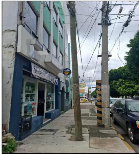
Fotografía 28. “Servicios básicos obstruyendo la banqueta”. Foto propia. Hernández A y Tinajero E. (2024)
