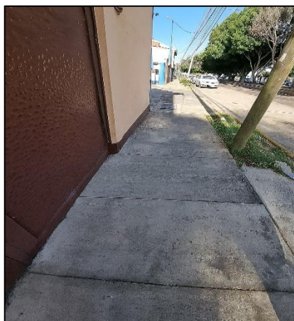
Fotografía (25 IA). “Recreación digital de banqueta reparada”. Imagen generada por inteligencia artificial con asistencia de Chat GPT (modelo GPT-5), OpenAI (2025).
