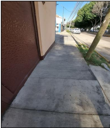
Fotografía (27 IA). “ Recreación digital de banqueta reparada ”. Imagen generada por inteligencia artificial con asistencia de Chat GPT (modelo GPT-5), OpenAI (2025).
